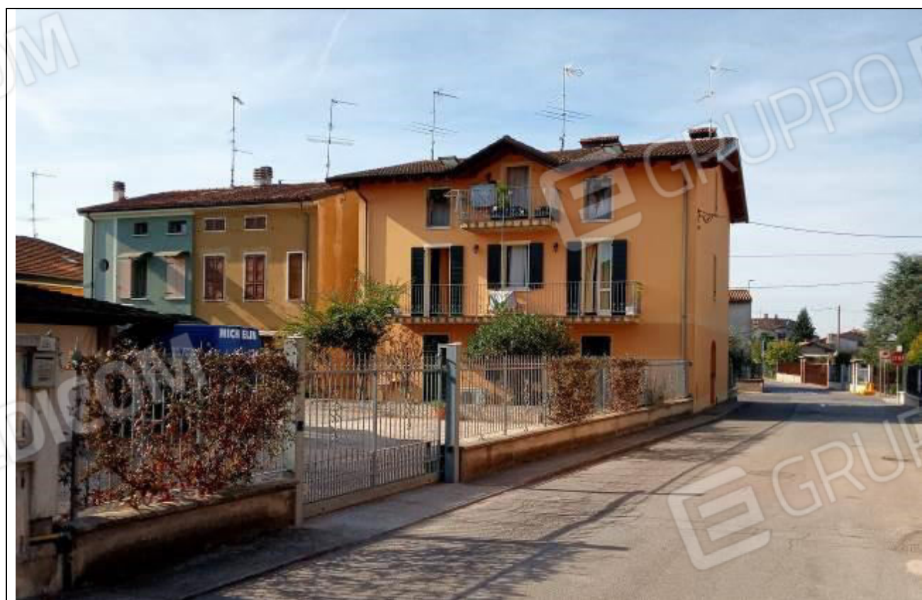
Vista da Via Monte Grappa
