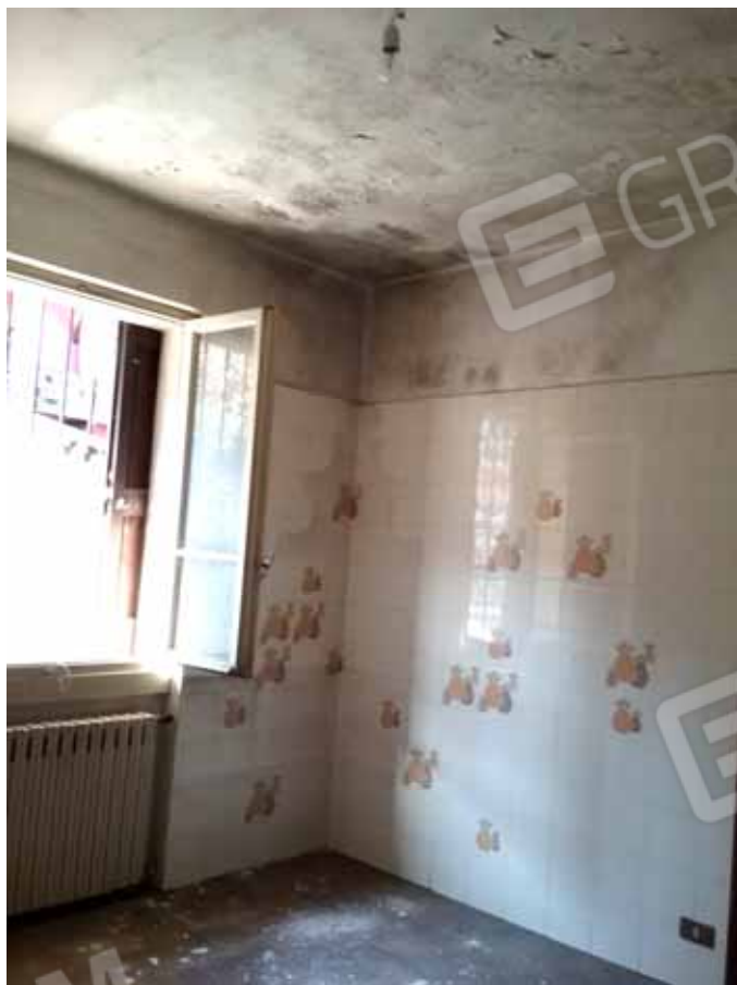
FOTO 5: Veduta interna della cucina – LOTTO n. 6
