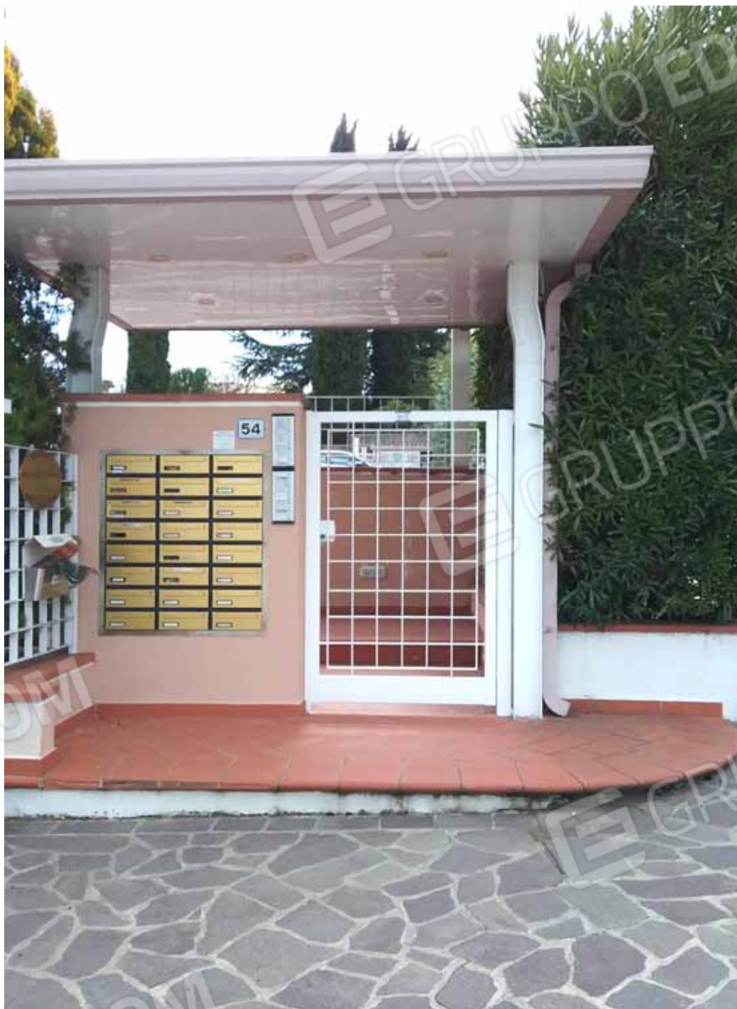
FOTO 6: Accesso pedonale dal n. civico 54 di via degli Alpini
