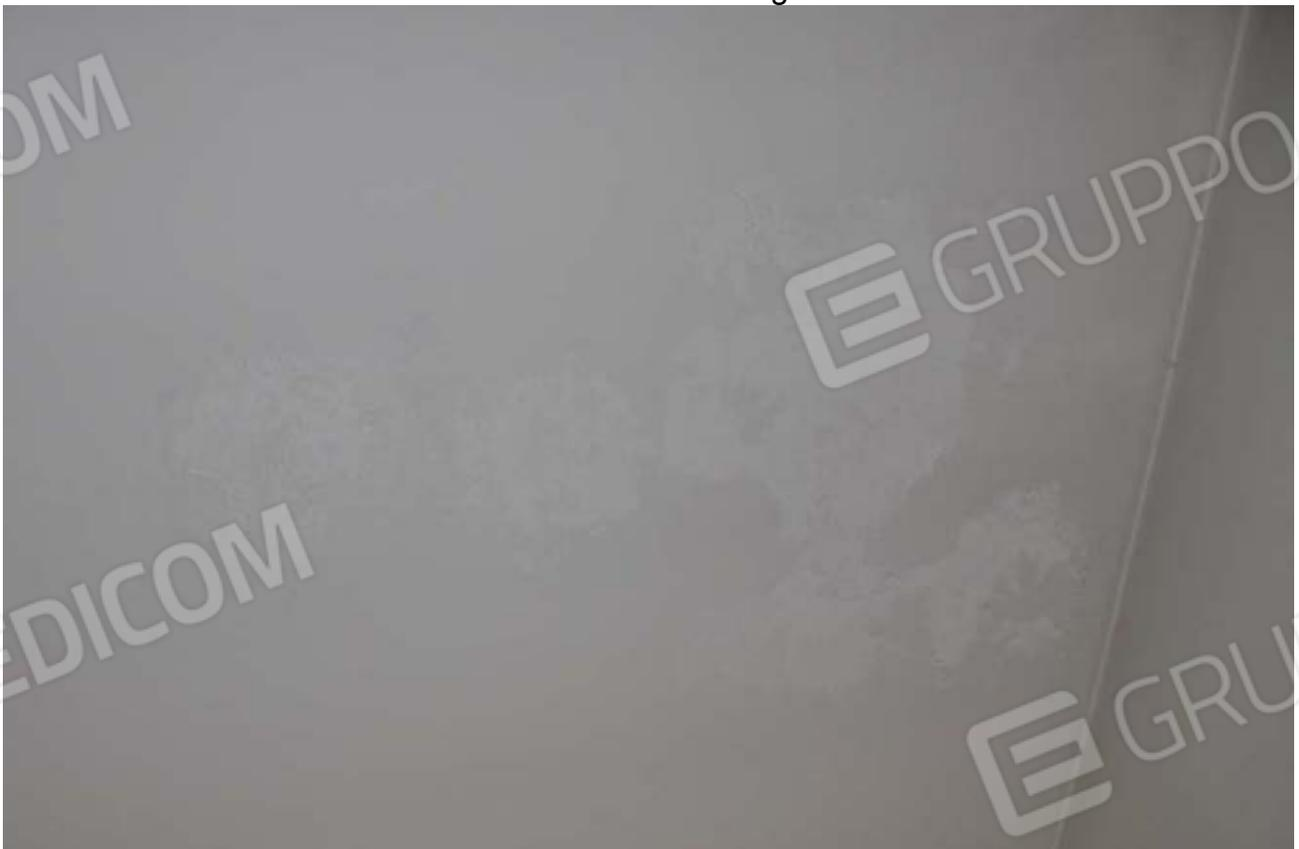
Foto n°12: Segno d'Infiltrazione sul soffitto del soggiorno
