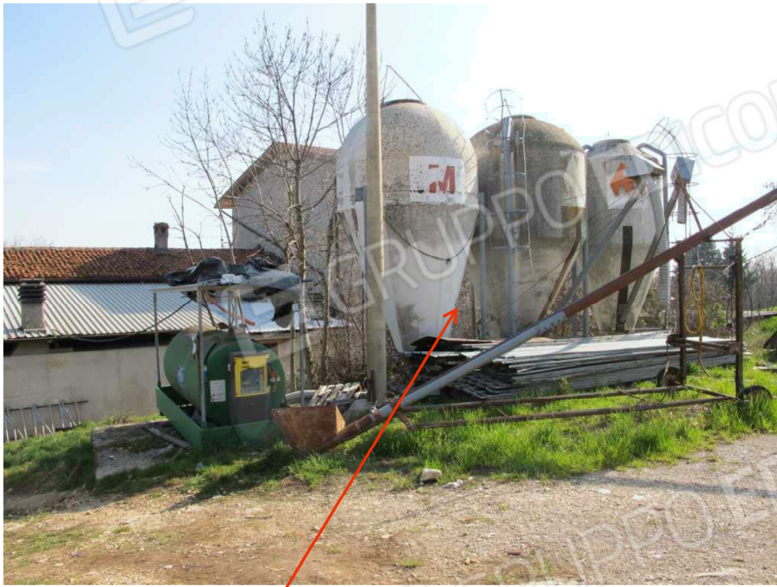
Silos con basamento in cemento non autorizzati, con sedime sulla corte comune
