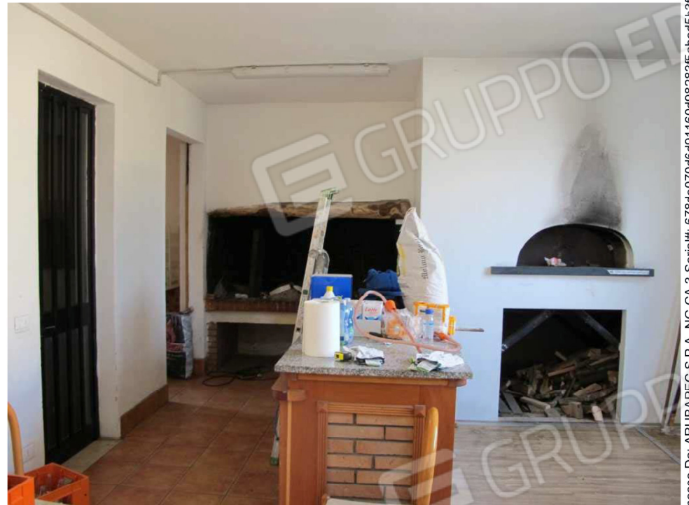
Vista interna del portico chiuso abusivamente
