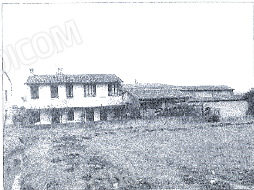
FABBRICATO PRINCIPALE e RUSTICO
