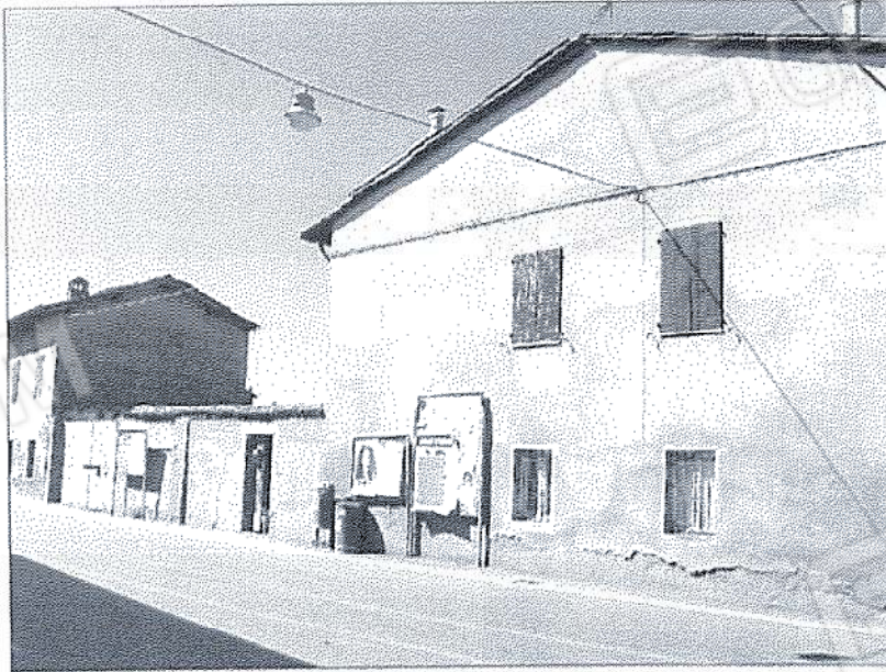
1B FACCIATA SU STRADA ALLOGGI
