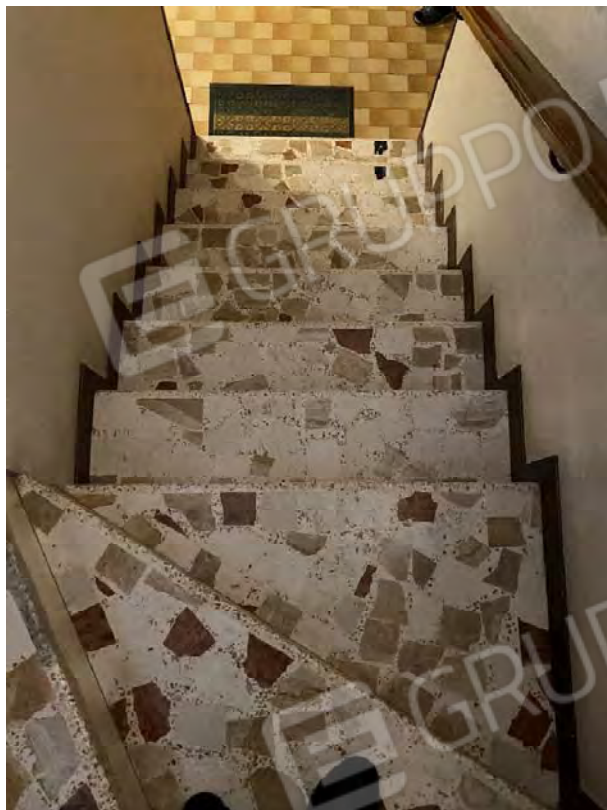
Scala interna di comunicazione tra piano rialzato e piano seminterrato
