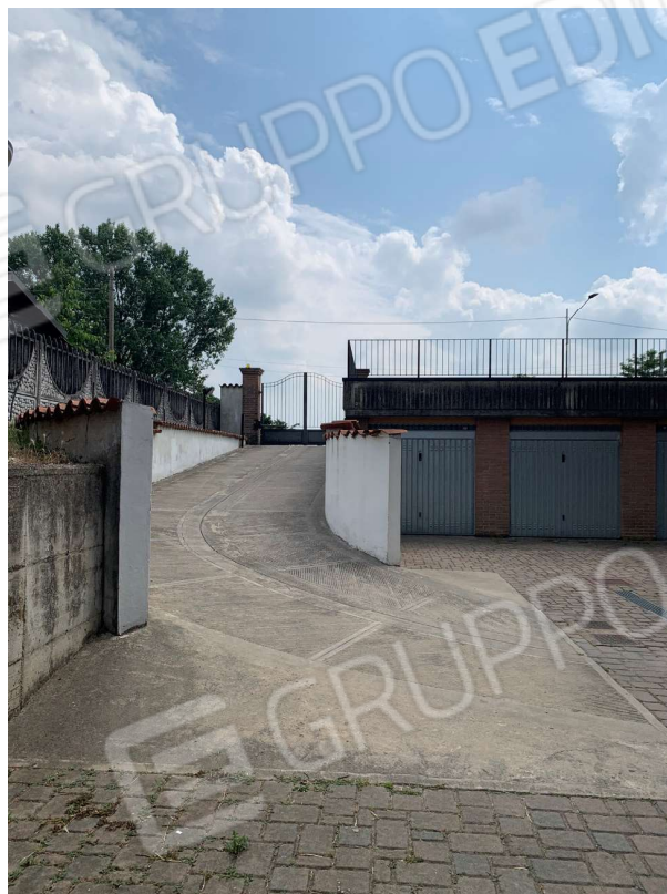
VISTA INTERNA ACCESSO CARRAIO
