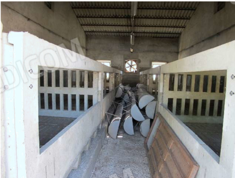
Vista interna Stalla Fabbricato A
