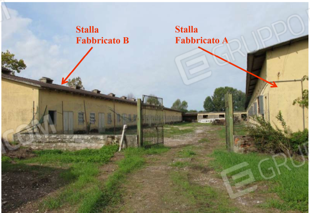
Accesso dal terreno mapp. 134
