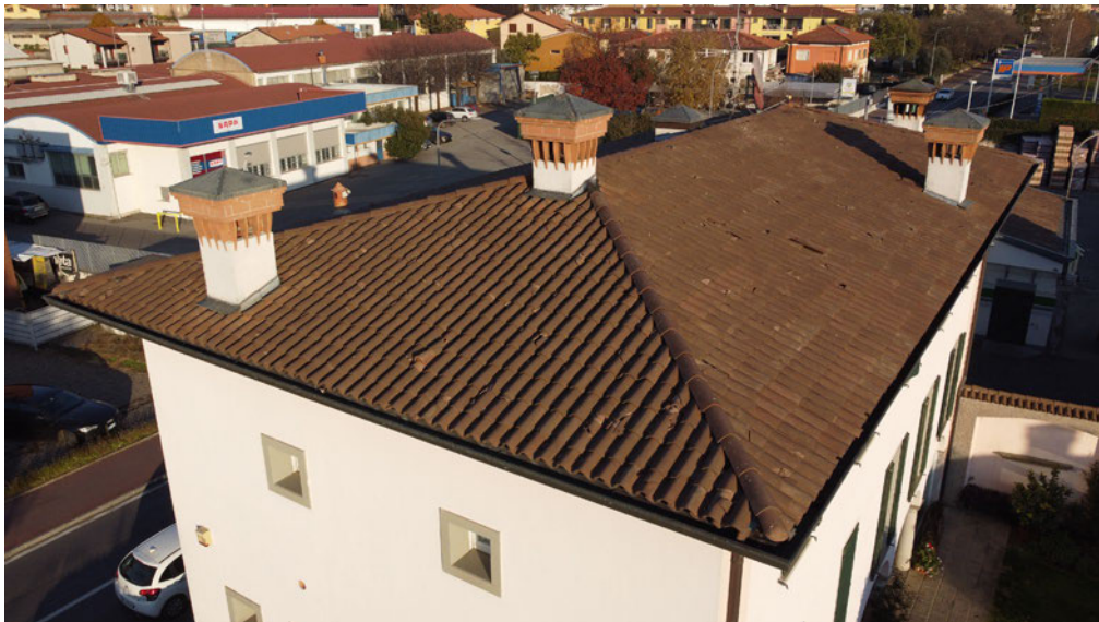
Vista della copertura con danni ai coppi
