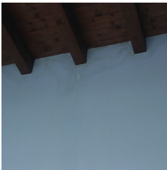
Vista dell'infiltrazione localizzata n. 1 uffici
