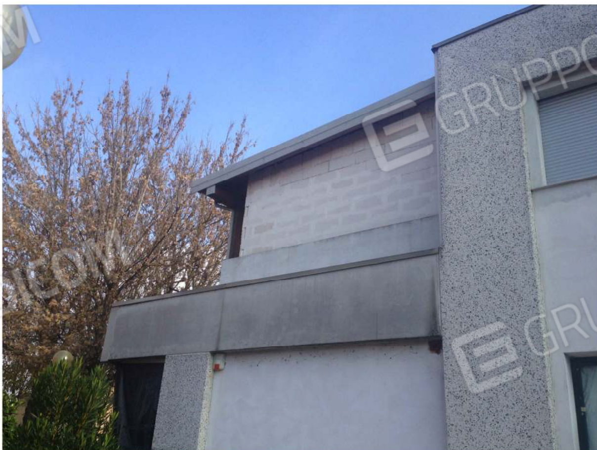
VISTA ESTERNA DELL'AMPLIAMENTO
