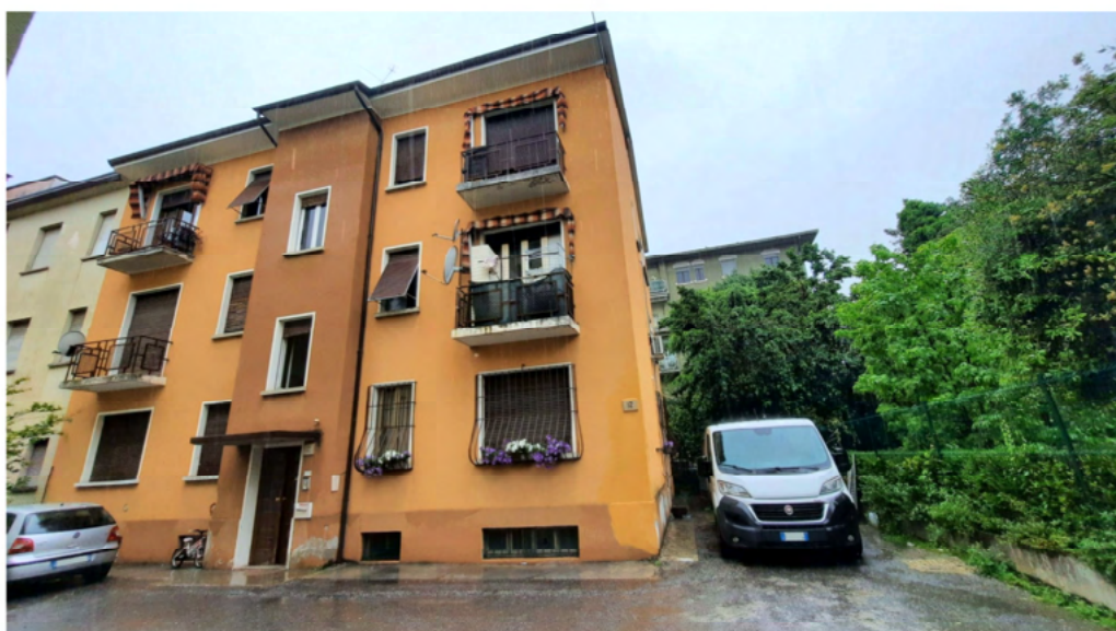
FOTO 1: PROSPETTO LATO EST
