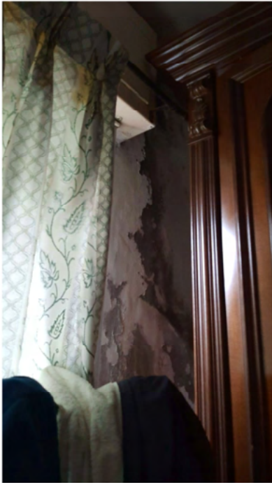
FOTO 16: AMMALORAMENTI IN CAMERA
