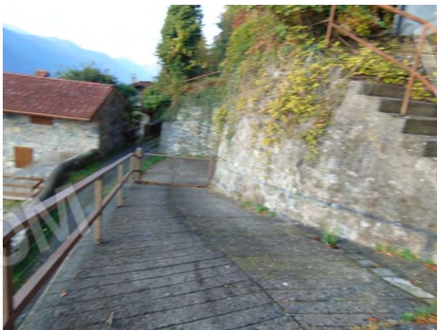
Rampa di accesso
