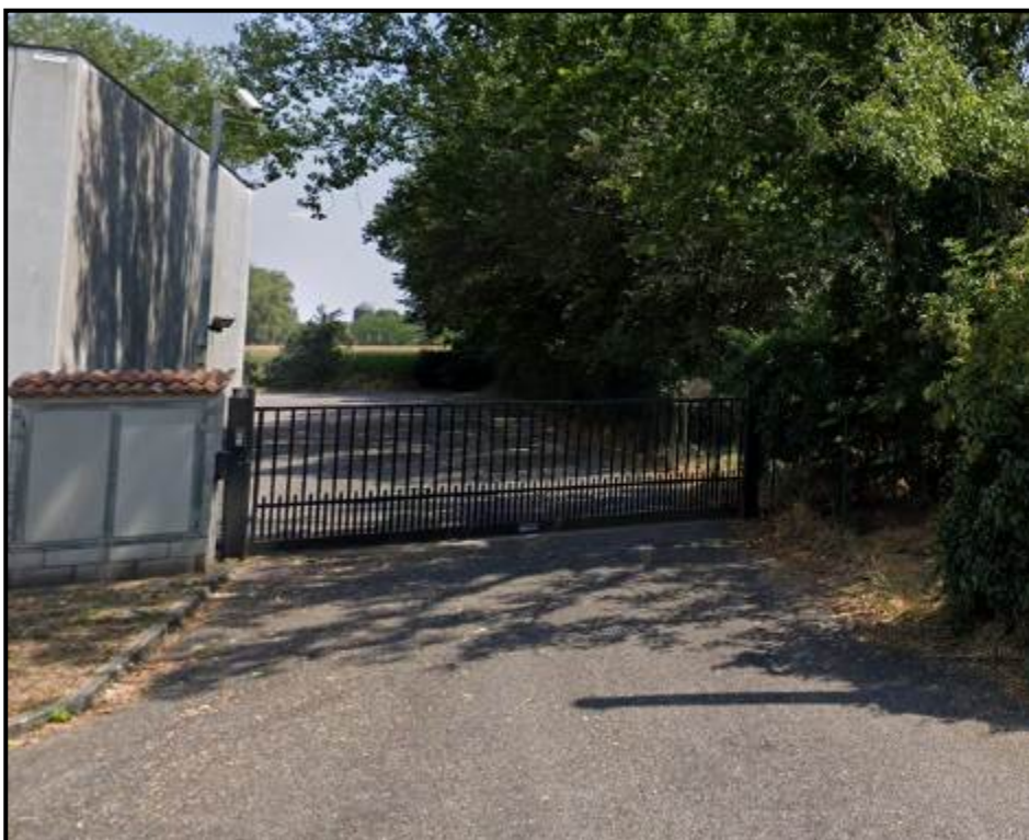
Foto n. 2 Ingresso su mapp. 128
