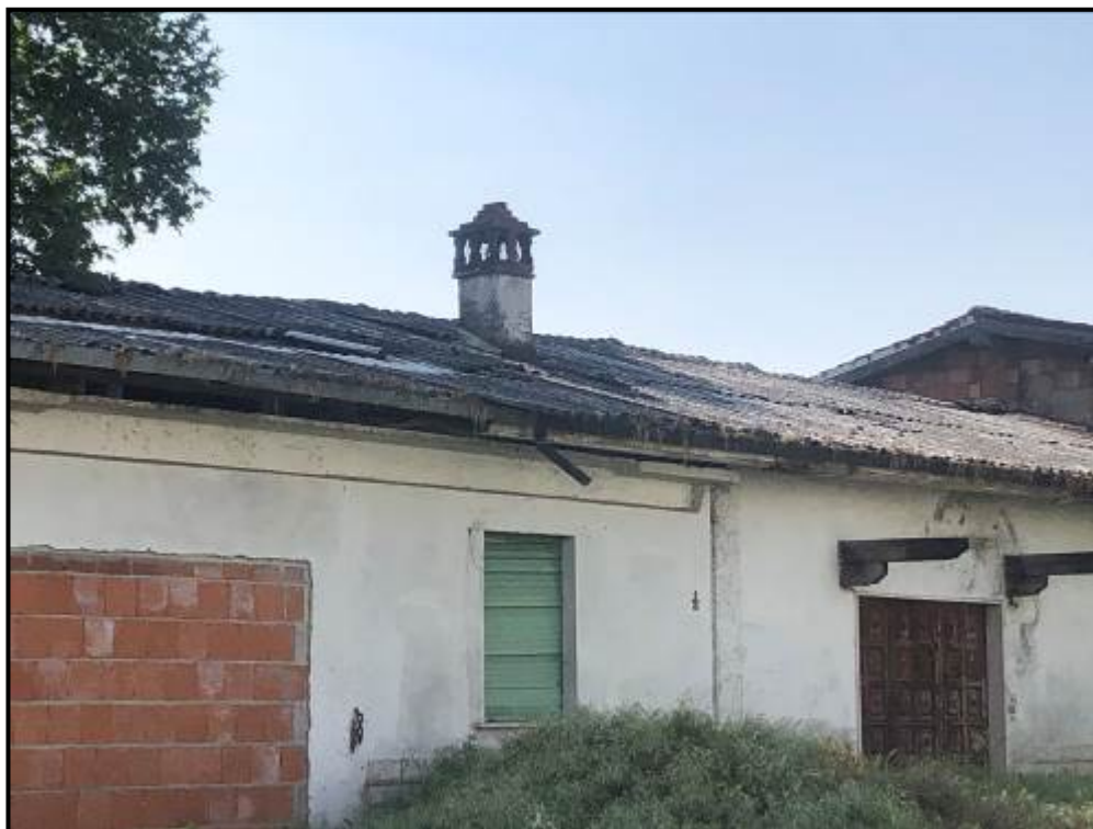
copertura in cemento-amianto
