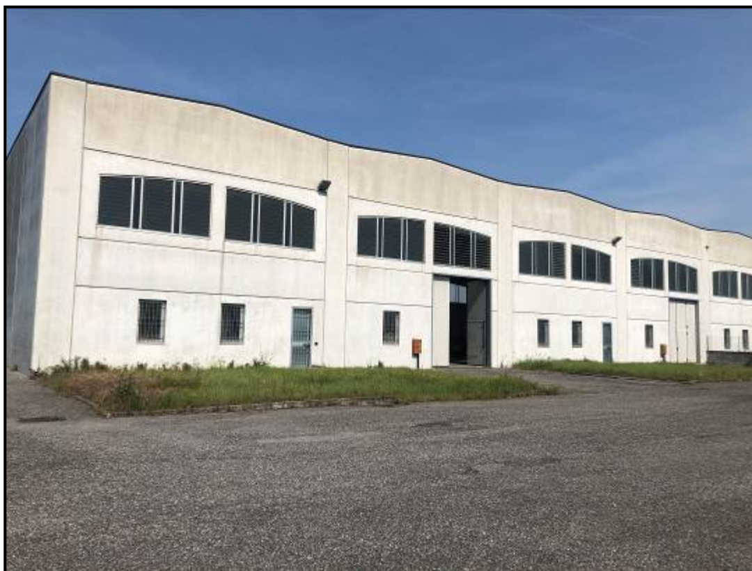
Foto n. 4 Sub. 2 - prospetto est
