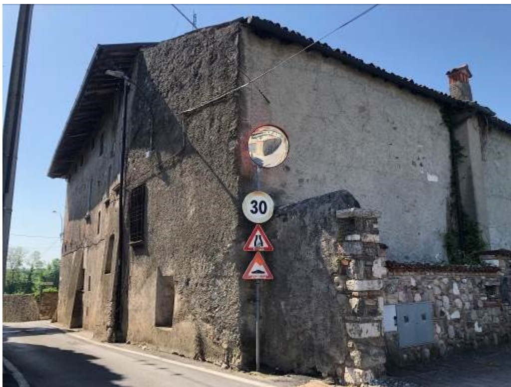
Prospetto su via Santo Stefano
