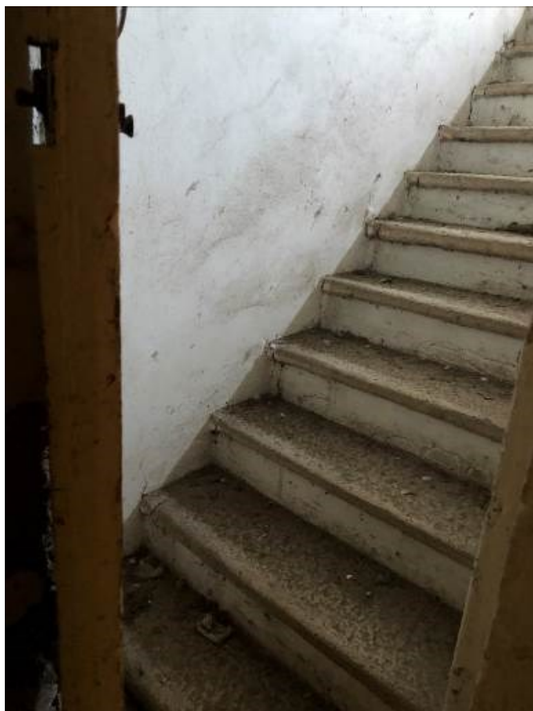
Foto n. 12 - Interni zona residenza
