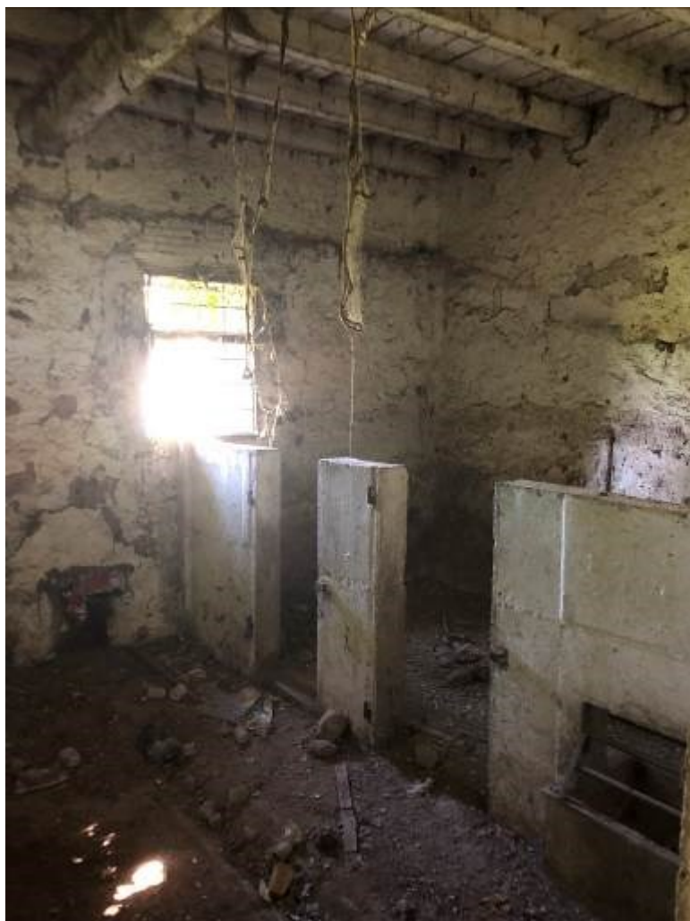
Foto n. 18 - Interni zona locali accessori
