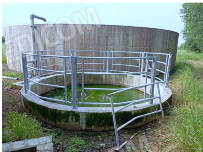
4 e 5. Vasche di raccolta dei liquami poste sul Fig. 33 Mapp. 82
