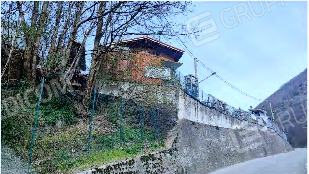
Foto n° 15 ( Facciate fabbricato – Fronte Sud dal basso )
