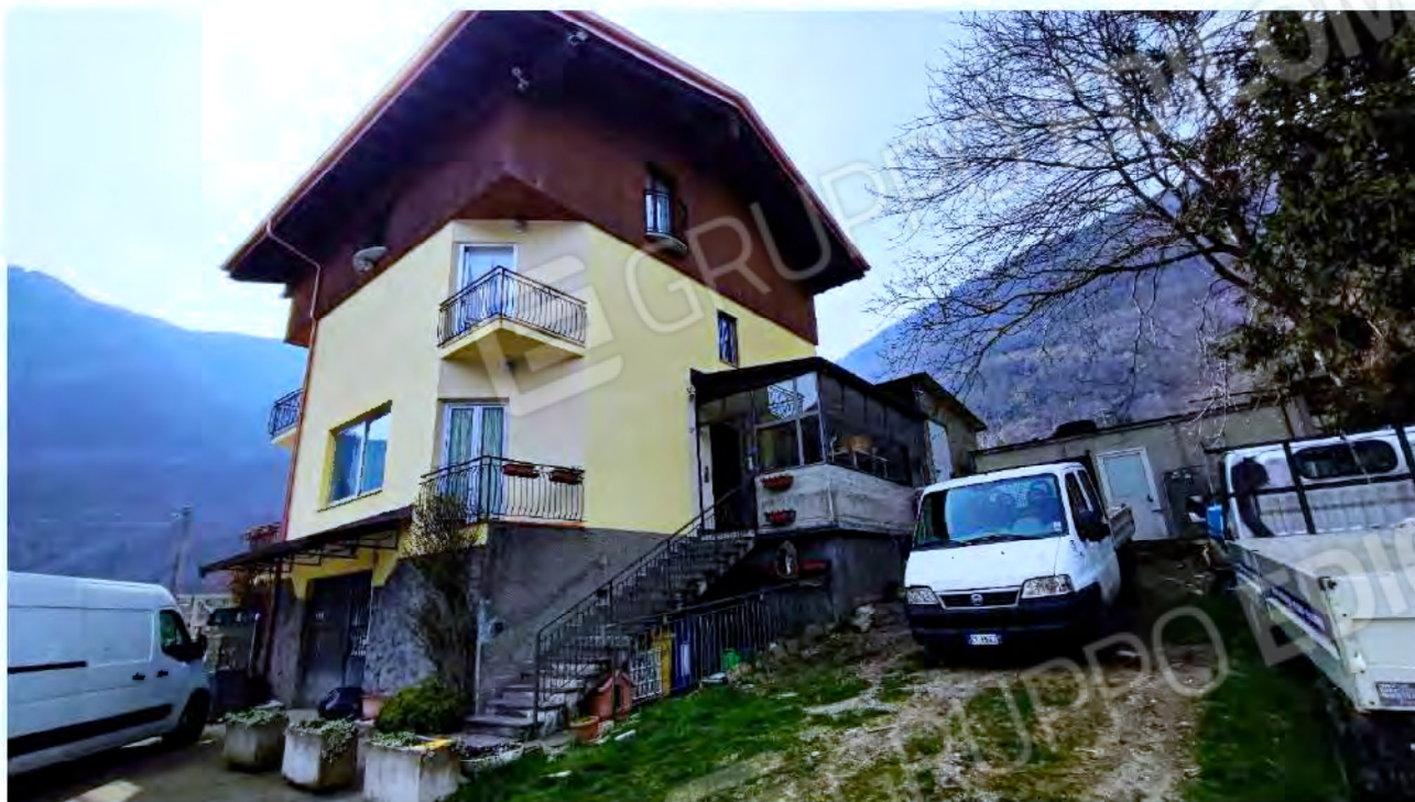
Foto n° 9 ( Facciate fabbricato – Fronte N/E )
