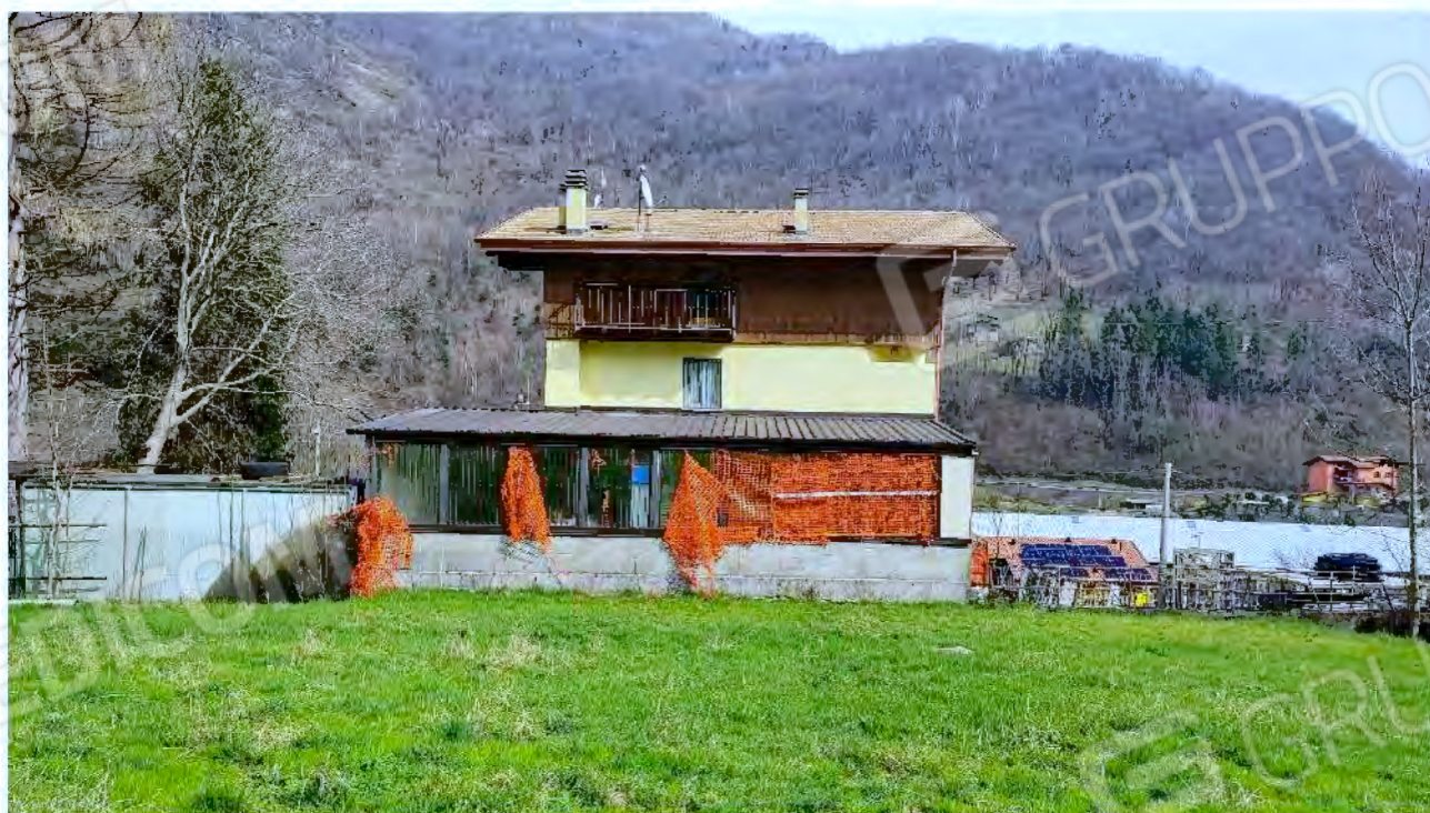
Foto n° 12 ( Facciate fabbricato – Fronte Ovest )
