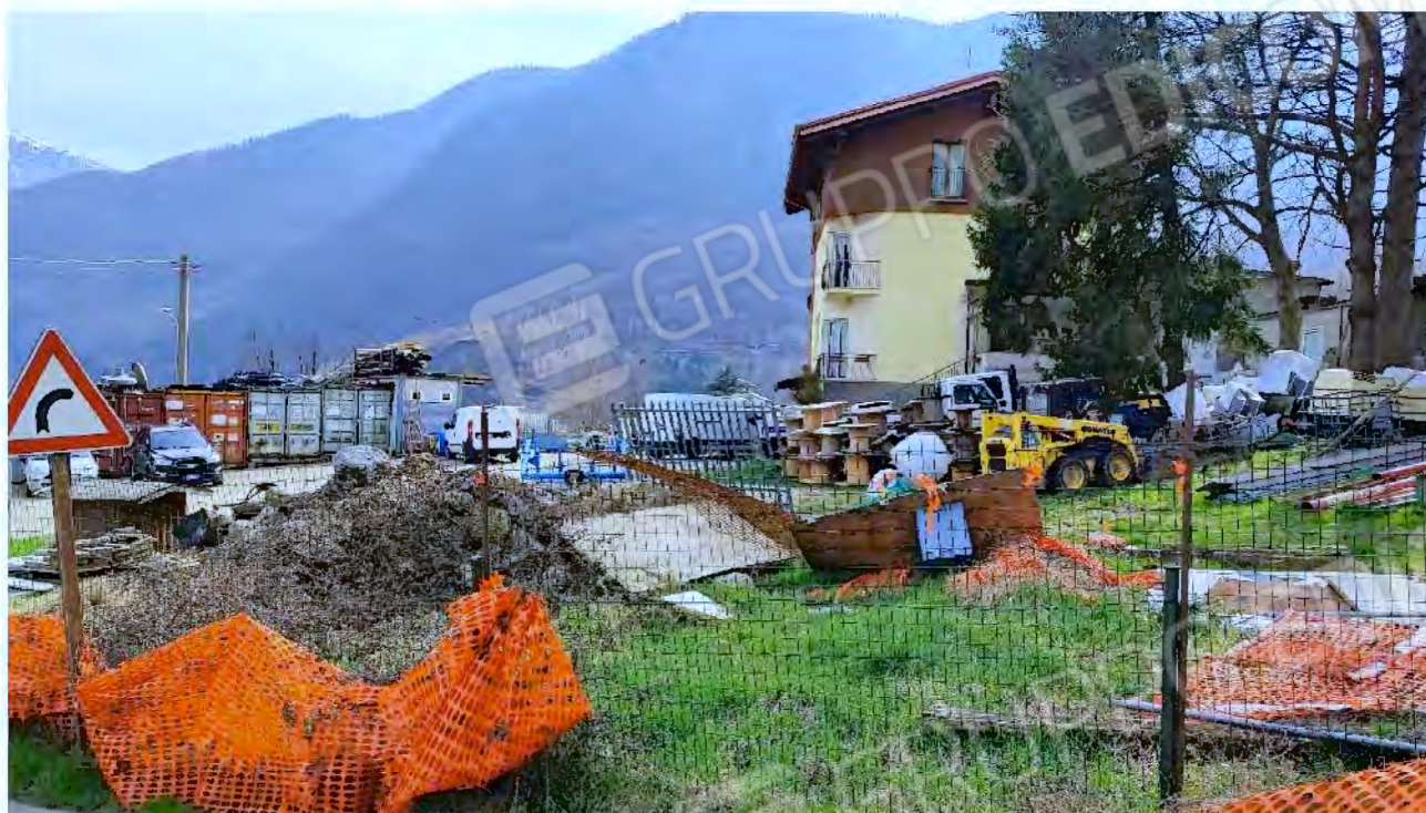
Foto n° 11 ( Facciate fabbricato – Fronte Nord )
