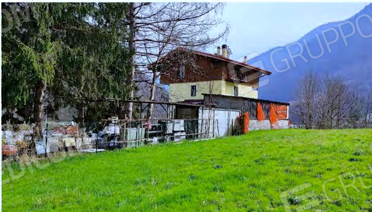
Foto n° 8 (Lato retrostante - Ovest )
