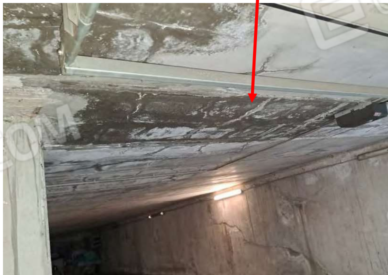
Segni evidenti di infiltrazioni
