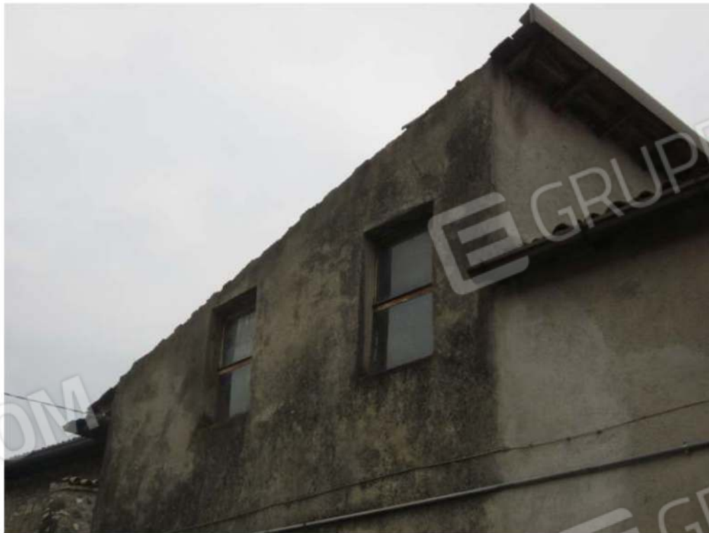
Fotografia 5: dettagli muffe facciata
