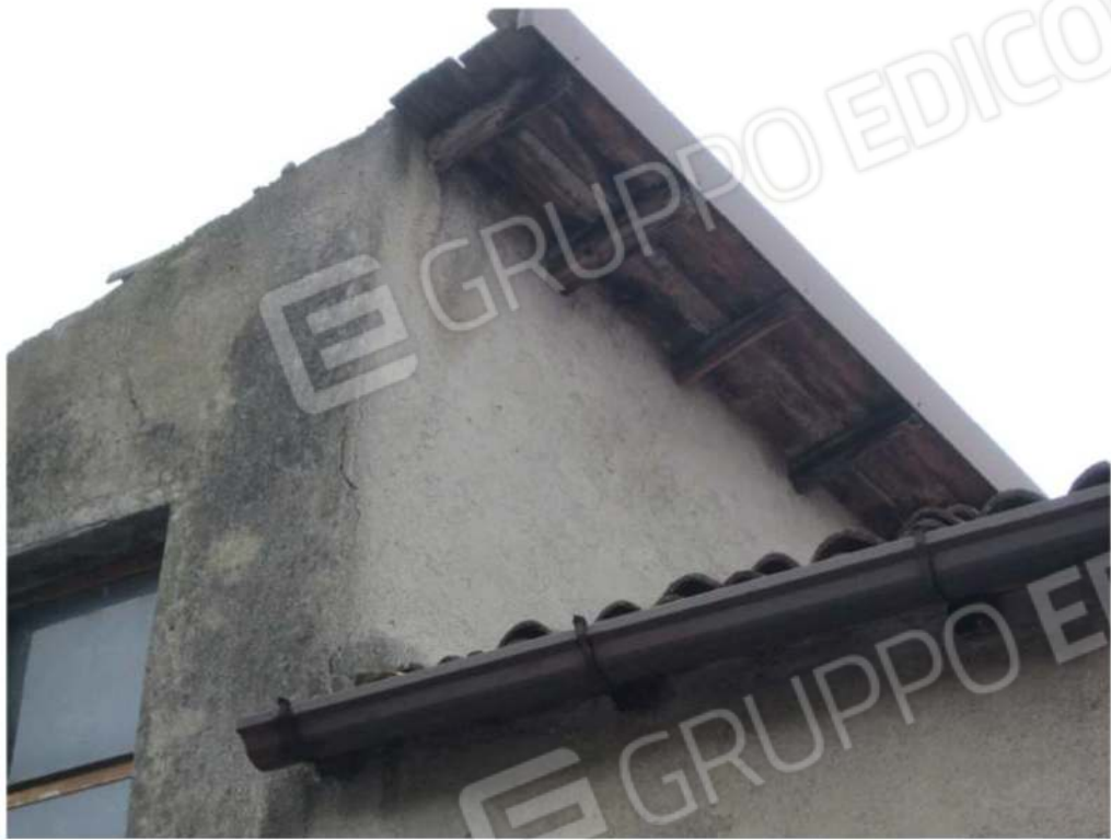
Fotografia 4: dettagli ammaloramento copertura
