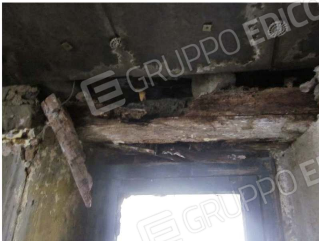
Fotografia 13: ammaloramento e marcescenze degli elementi lignei della copertura
