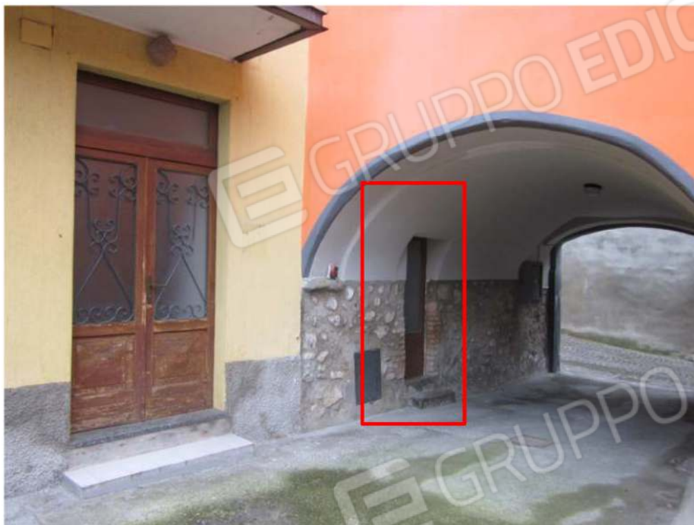
Fotografia 7: difformità segnalata: porta in luogo di finestra sotto l'androne
