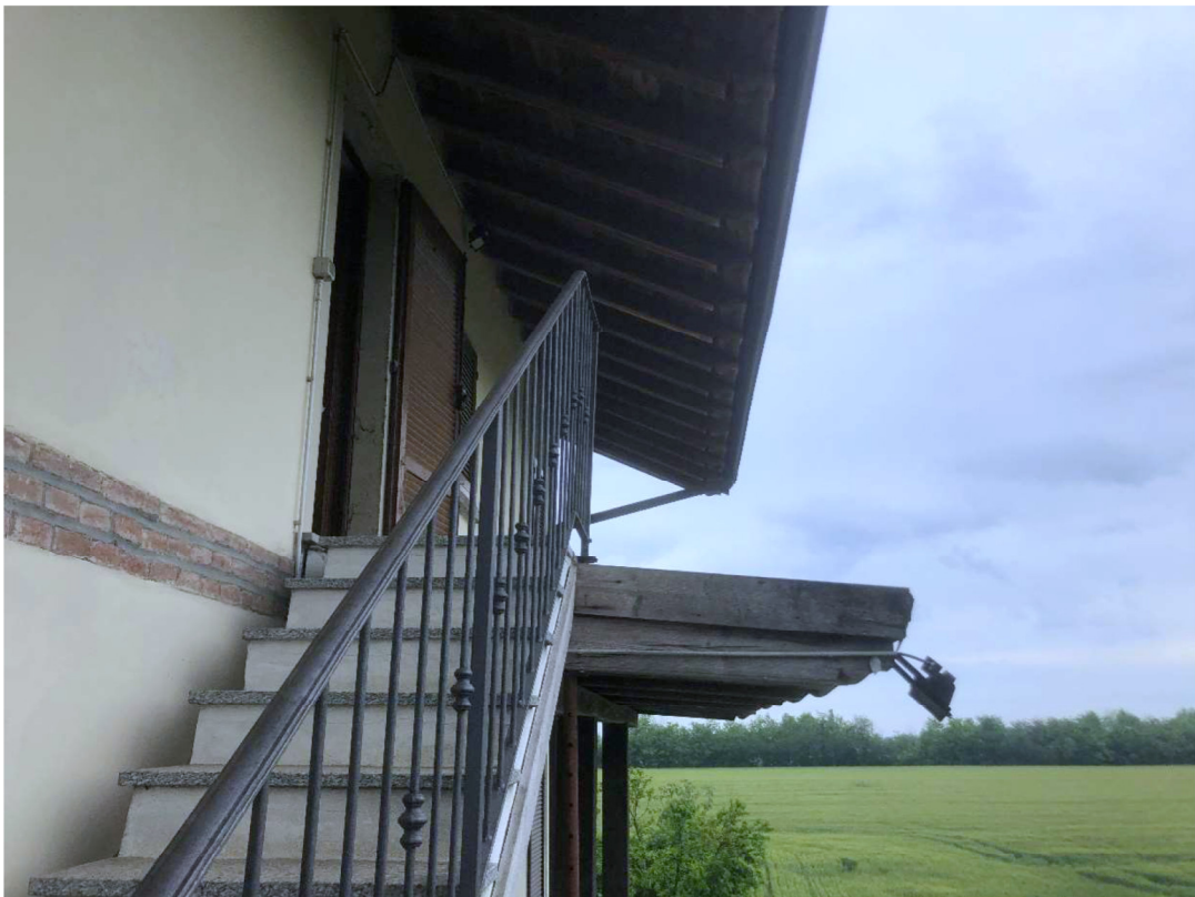
PIANEROTTOLO BALCONE DI ACCESSO AL SUB. 08 pericolante e privo di parapetto
