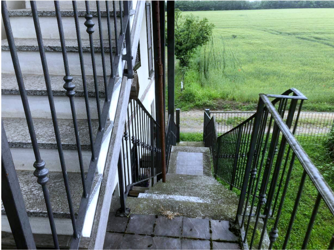
PIANEROTTOLO BALCONE DI ACCESSO AL SUB. 08 pericolante e privo di parapetto
