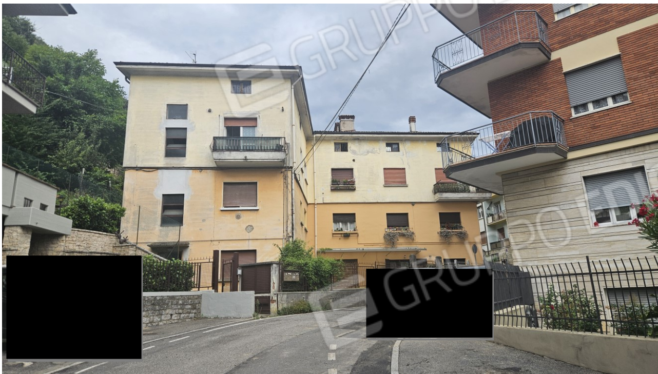
Fabbricato via A. Diaz n. 23
