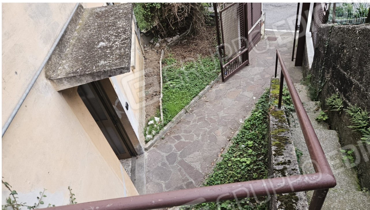
Prospetto interno cortile condominiale
