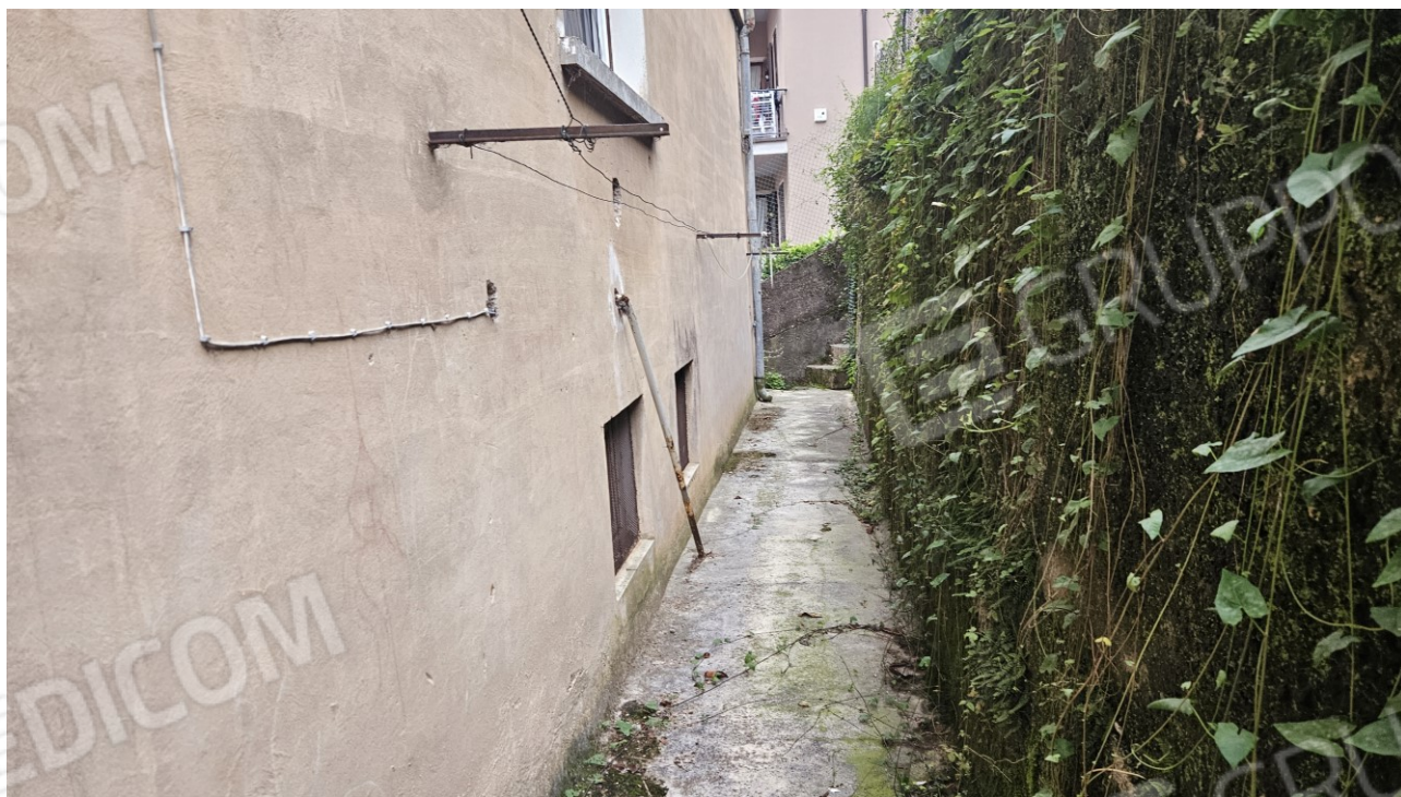
Corte condominiale esterna
