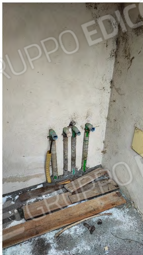
Foto n° 23 – 24 ( Bagno e sola predisposizione Caldaia - Sub 4 )
