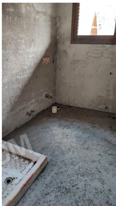
Foto n° 27 – 28 ( Sola predisposizione Bagno e Caldaia - Sub 7 )
