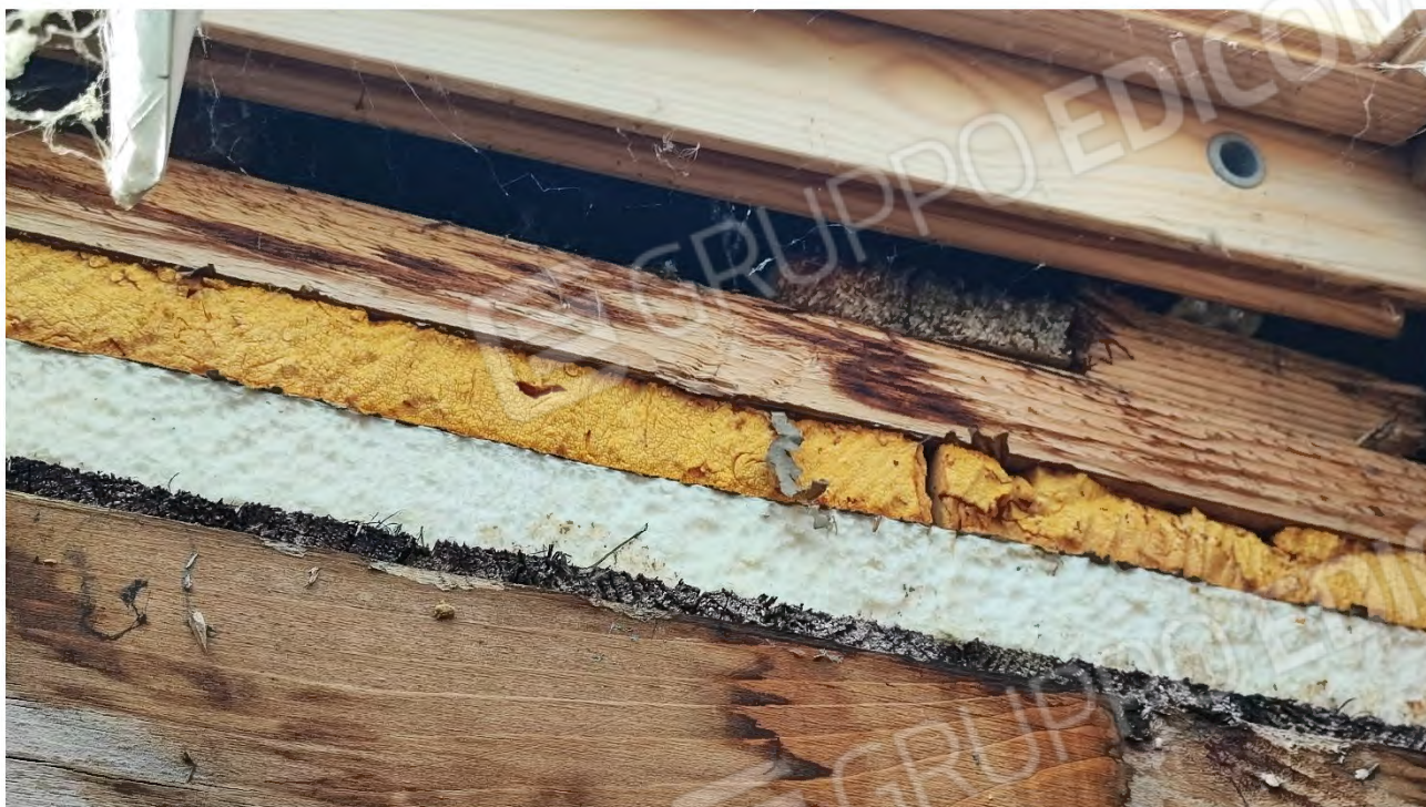
Foto n° 51 ( Spessori Isolanti Copertura )
