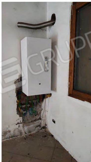
Foto n° 49 ( Caldaia non collegata - Sub 9 )
