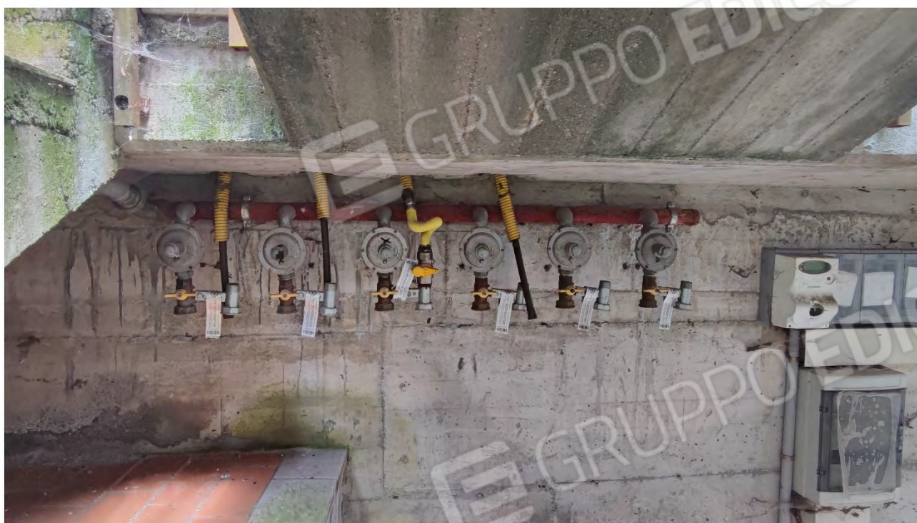
Foto n° 53 ( Predisposizione Allacciamento Gas Metano )
