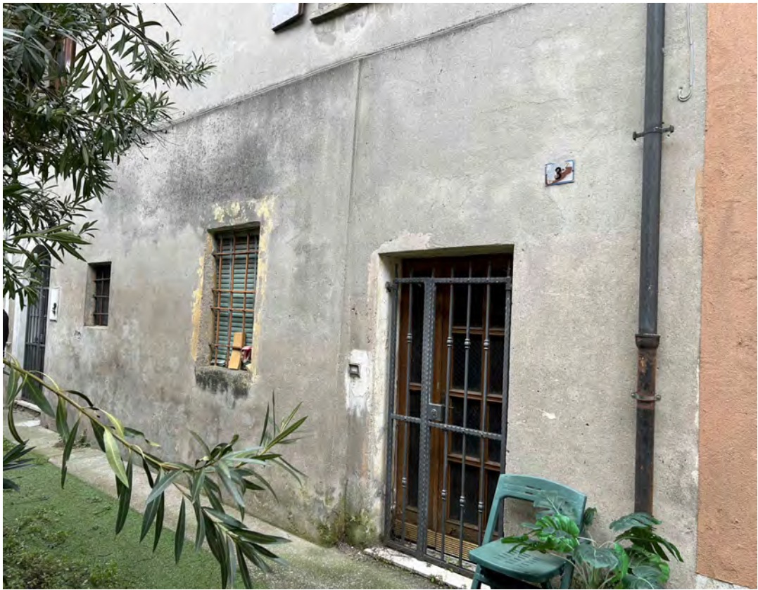
Primo ingresso Vicolo Moè
