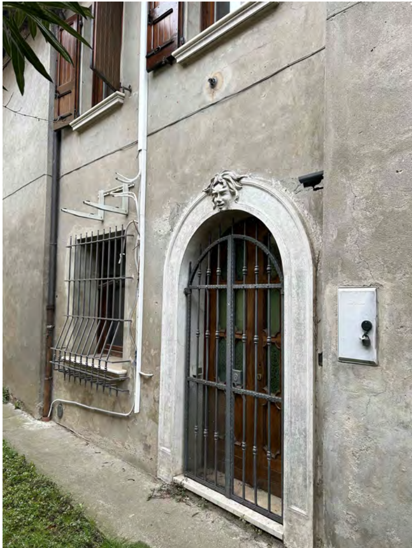
Secondo ingresso da Vicolo Moè
