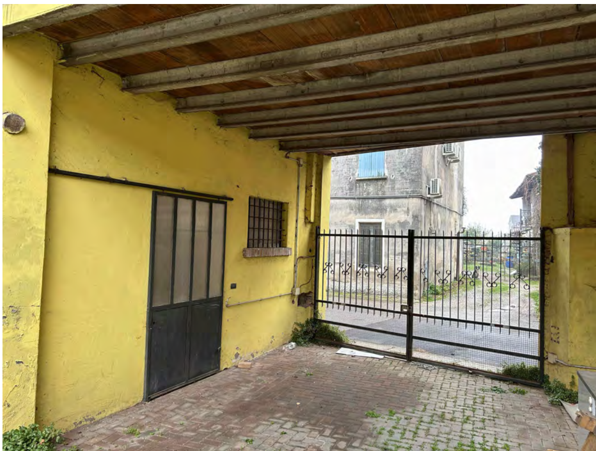
Androne accesso coperto da Via Cremonesi 6
