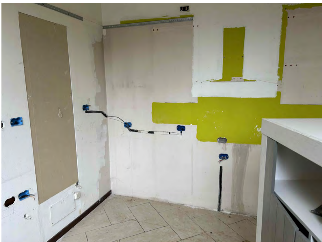
Locale lavanderia P.T.
