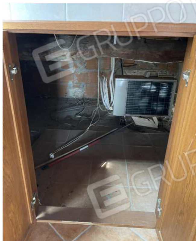
FOTO 27: Unità ext. a/c ubicata nel sottotetto Nord
