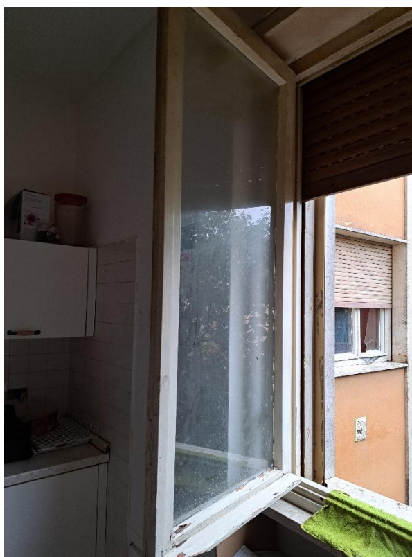
Serramento finestra in legno con applicato vetro singolo
