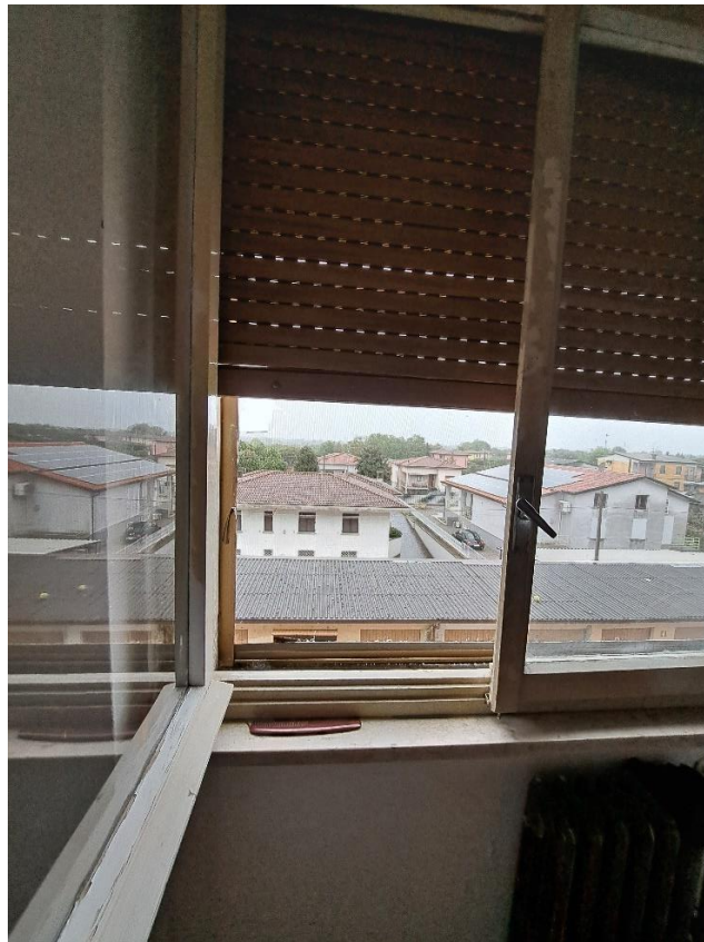
Vista camera 1 – finestra in legno con vetro singolo, tapparella e cassonetto, in pessimo stato di conservazione.
