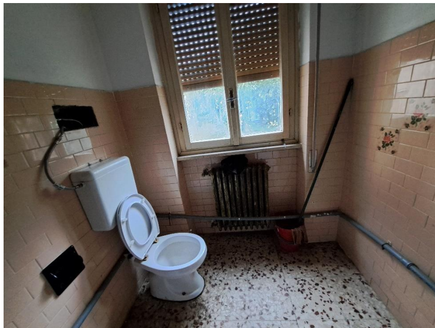
Vista del bagno: wc, cassetta di lavaggio wc, tubazione esterna di scarico dell'acqua della lavabiancheria
