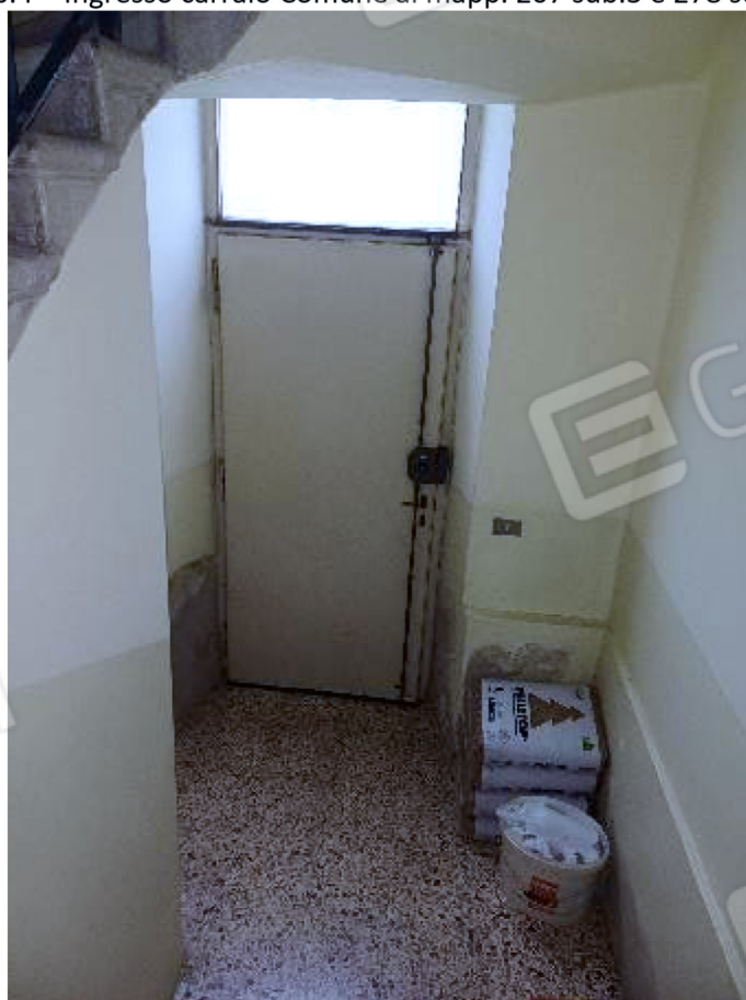
Sub.5 Ingresso comune scala lato nord della villa
