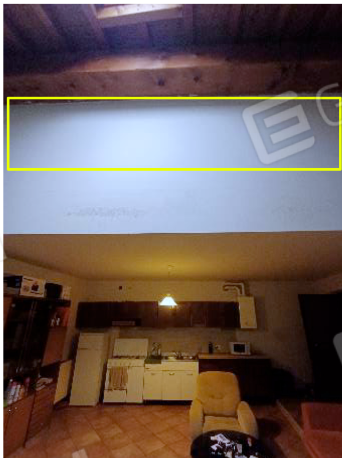
Muro soppalco da demolire fino a metri 1,10 dal pavimento
