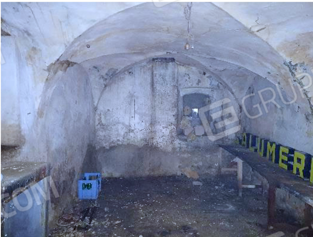
Cantina Legnaia PT Sub.7
