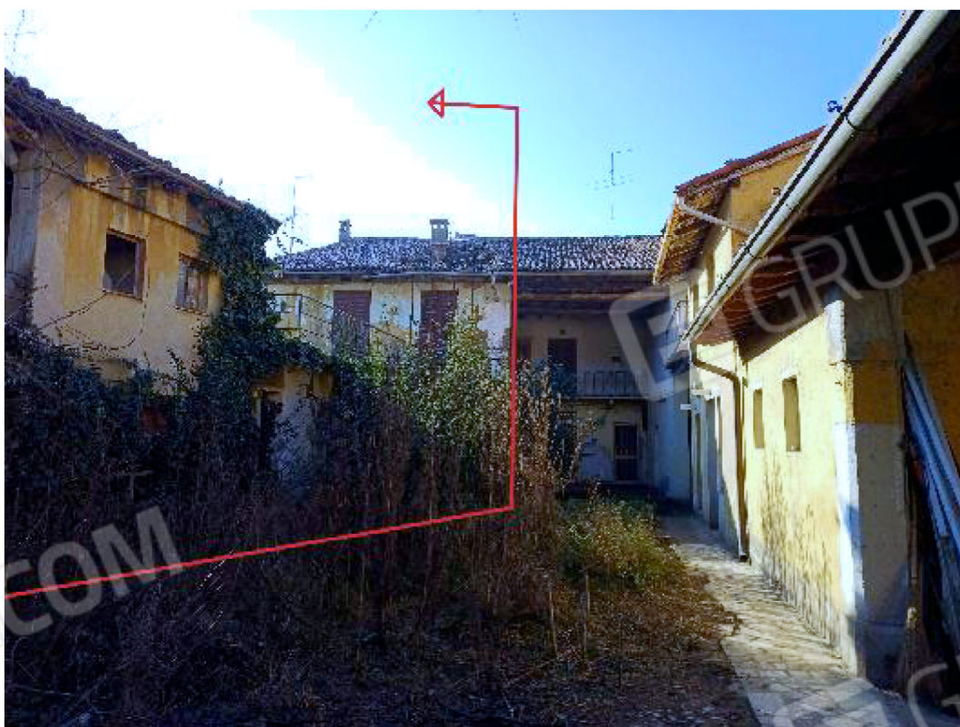
Porzioni oggetto di pignoramento – dal cortile comune – vista a sud
