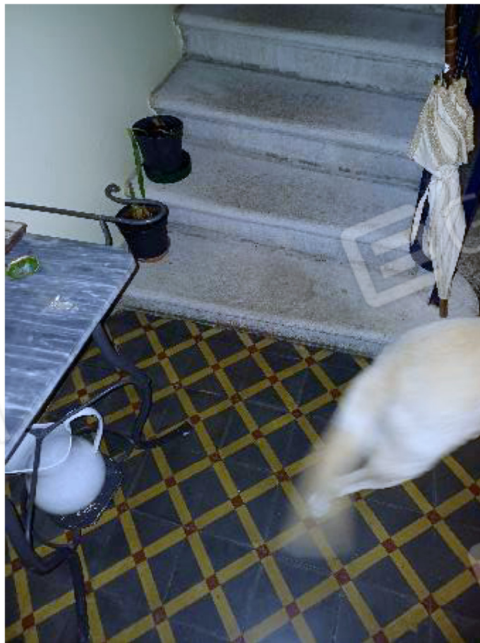
Scala comune con sub.2 (su.5)
