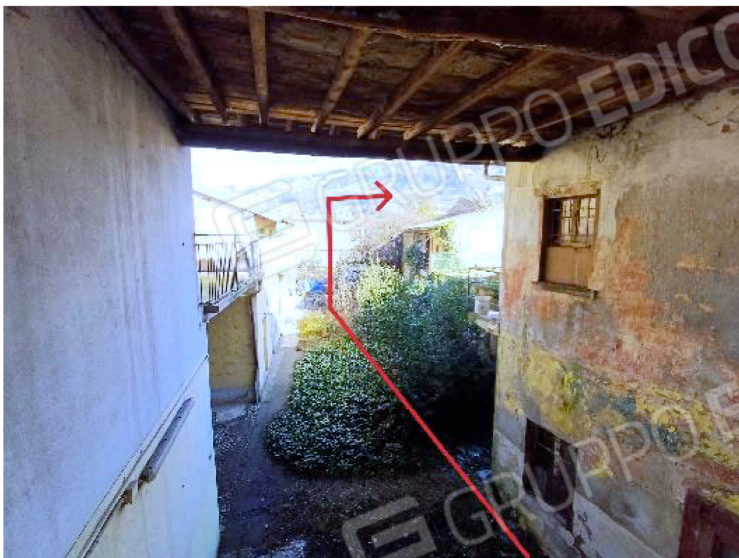
Porzioni oggetto di pignoramento – dal cortile comune – vista a nord
