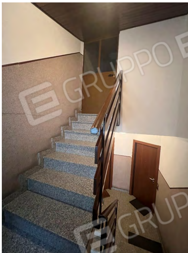
Scale comuni interne - Ingresso al sottotetto
