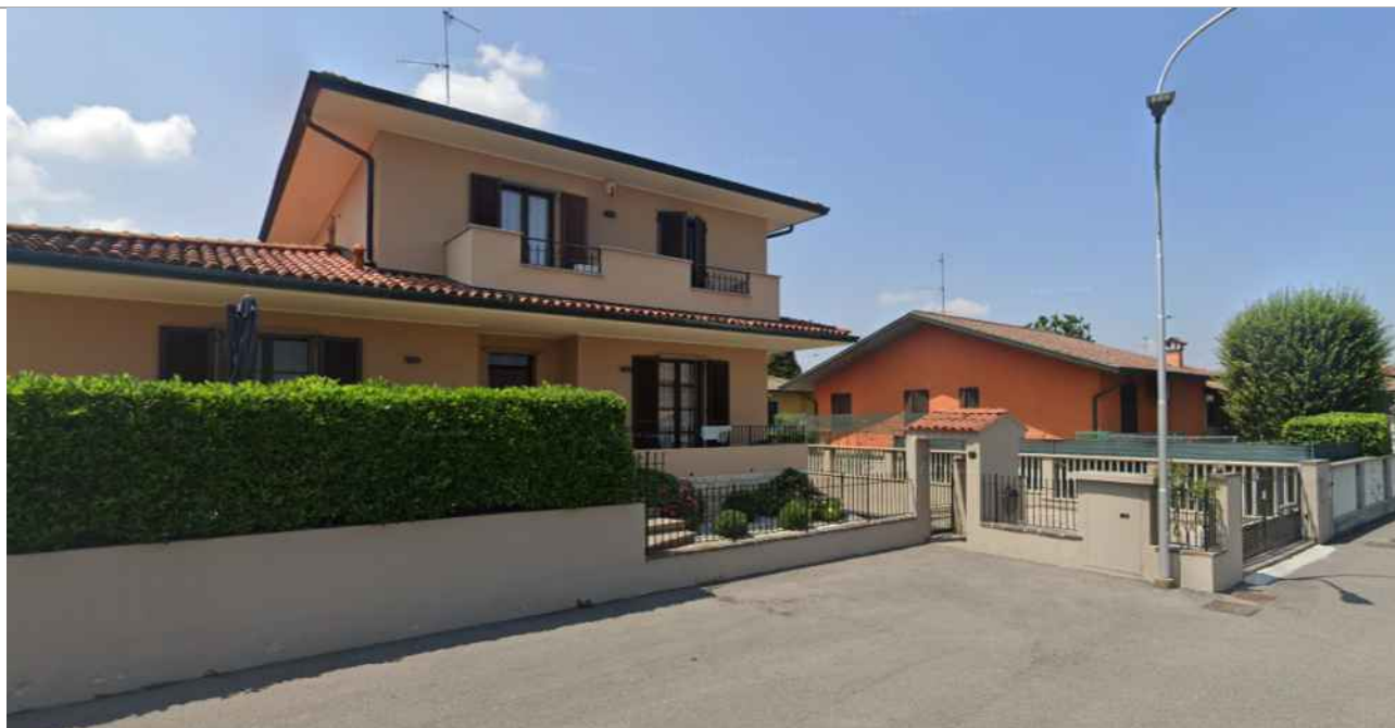
Ingresso pedonale in lato est
