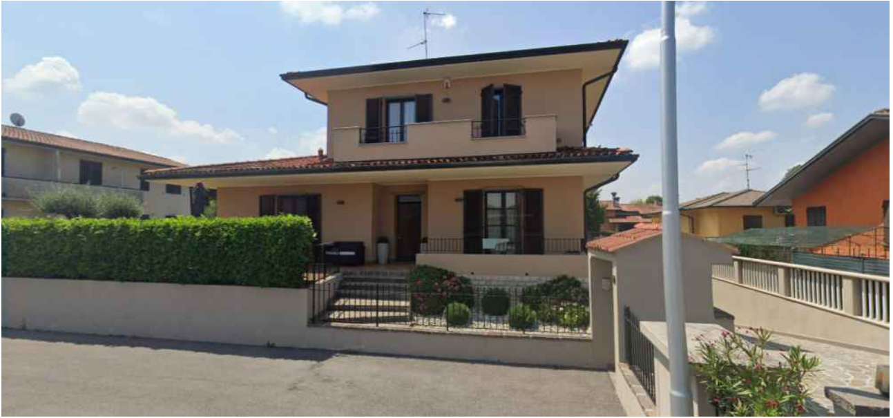
Fronte principale lato est da via Aldo Moro
