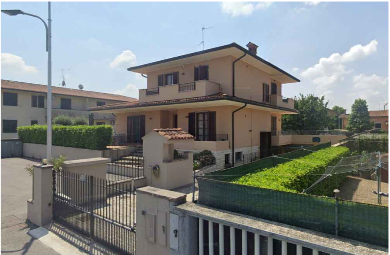
Ingresso carraio in lato est
