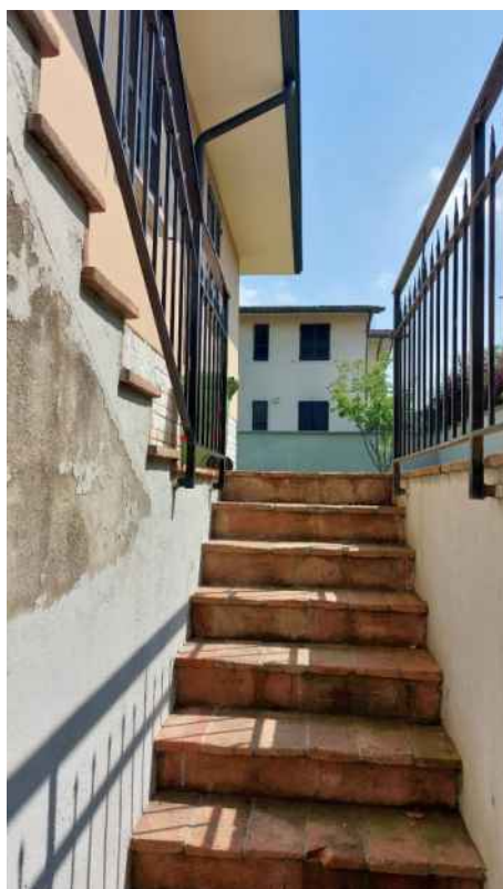
scala di accesso esterna all'autorimessa (sub 5)
