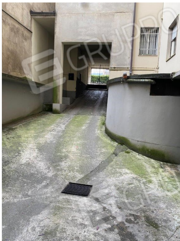
Rampa di accesso allo scantinato comune
