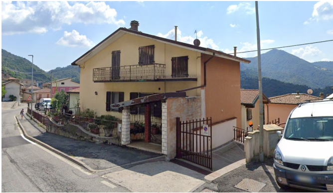
Foto 1 da Est, 2 frontale ingresso (Nord) e 3 da Ovest.
