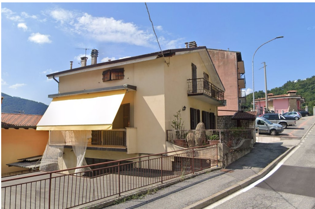
Fig. a lato. Fotografia dell'immobile oggetto di stima nel suo complesso visto da via strada. (Est).
