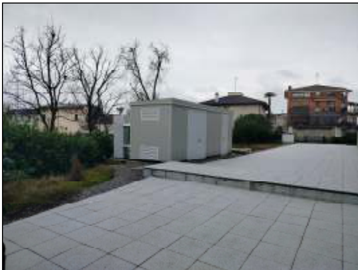
CABINA PER POMPE DI CALORE PER PRODUZIONE RISCALDAMENTO
