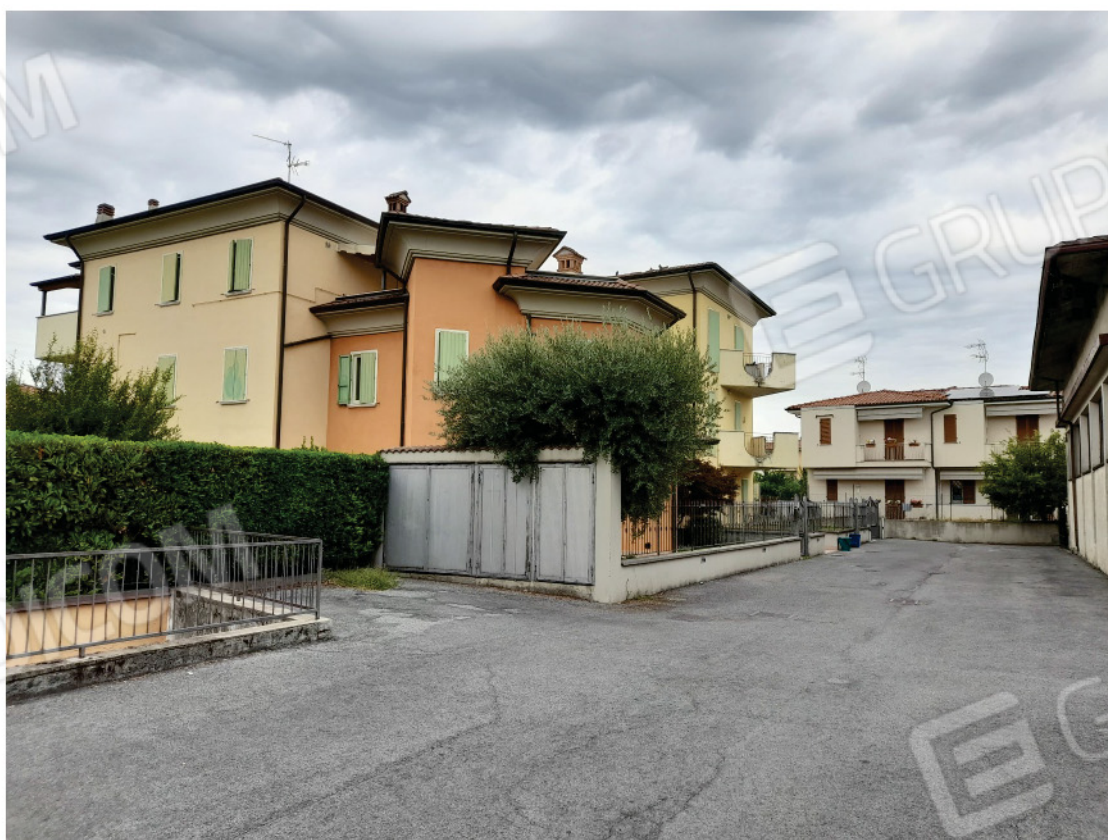
Foto 2 vista del prospetto nord lungo via Toscana
