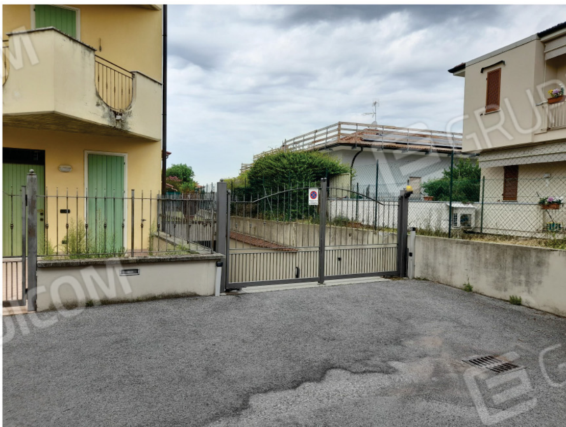
Foto 6 vista dell'ingresso carraio comune
