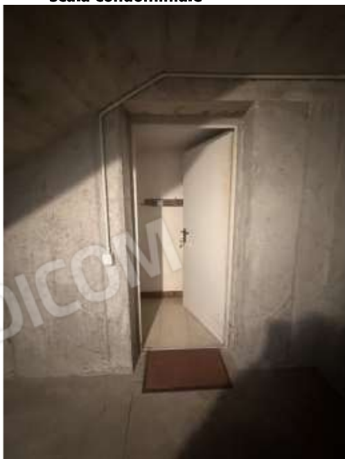
N. 55 Vista dell'ingresso alla cantina dal vano scala condominiale -
