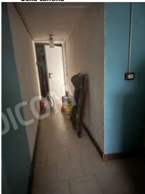
N. 63 Vista interna del corridoio di accesso della cantina
