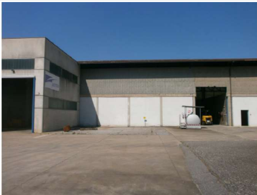
N. 10 - Dettaglio lato sud
