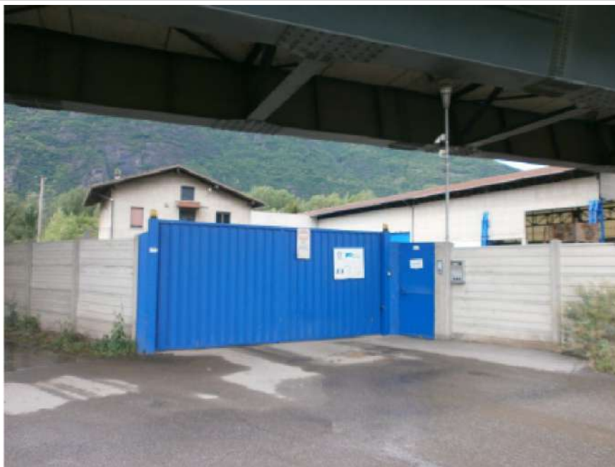
N. 20 - Vista ingresso carraio-pedonale sul lato est del lotto
