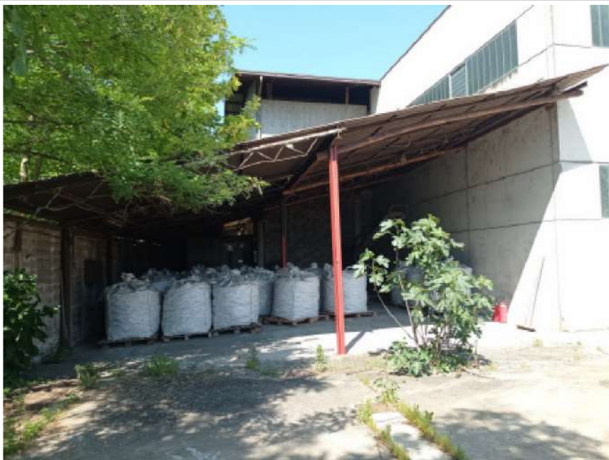
N. 12 - Vista portico sul lato sud
