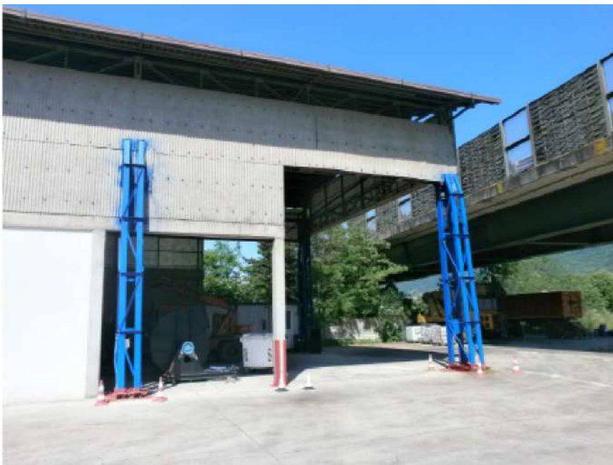
N. 5 - Dettaglio lato sud
