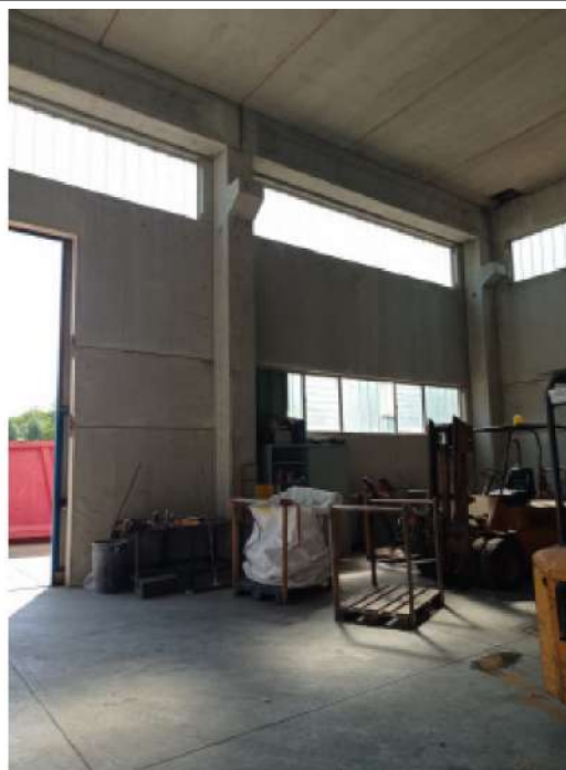
N. 33 - Dettaglio magazzino secondario
