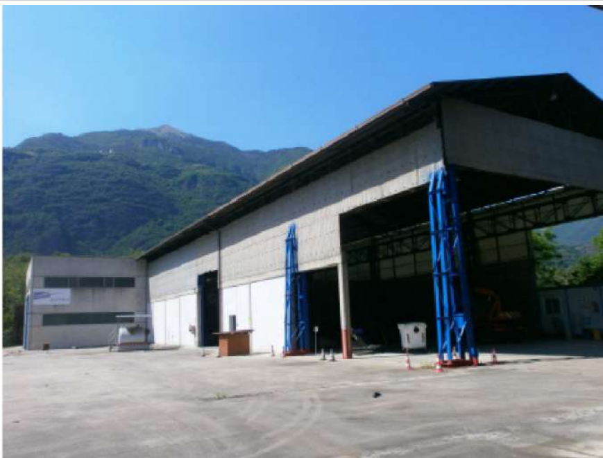
N. 4 - Vista generale, lato sud
