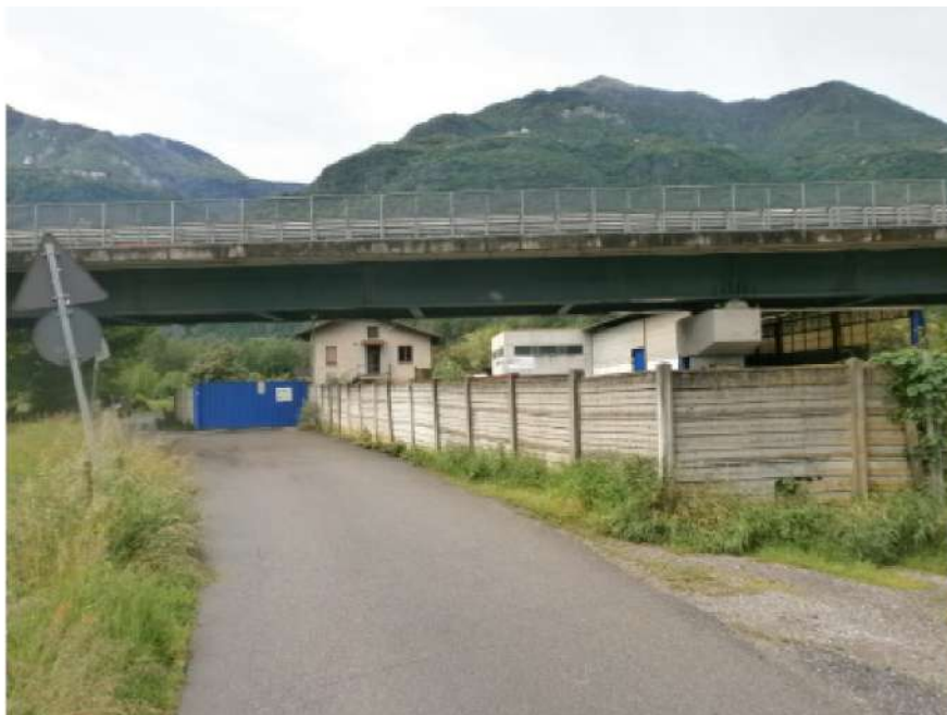
N. 21 - Vista ingresso da via Fermi, con la soprastante superstrada 42 della Val Camonica.
