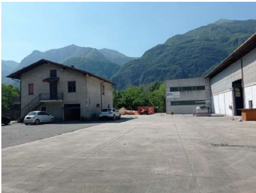
N. 13 - Vista generale, con casa custode
