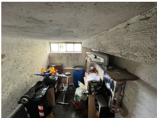
Interno cantina al piano terra
