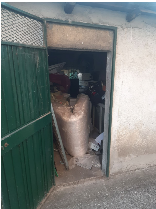
Interno locale ripostiglio
