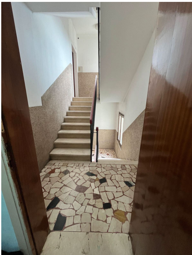
Vano scala condominiale
