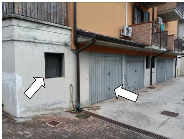
SPAZIO MANOVRA AUTORIMESSE (la frecce indicano l'ingresso dell'autorimessa dell'abitazione e la finestra della lavanderia)
