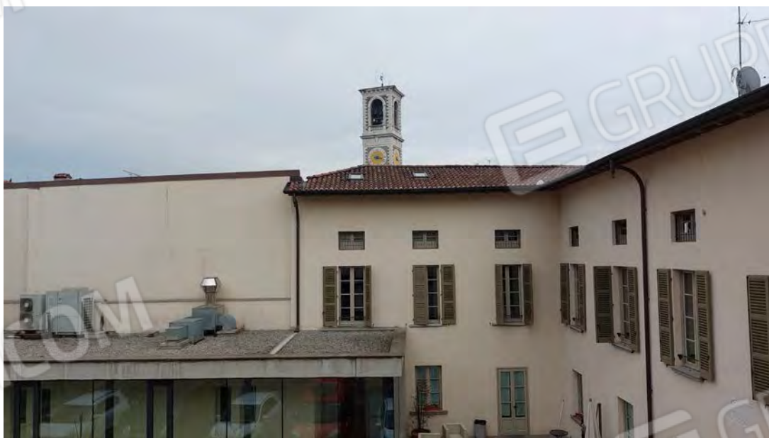
Interno del cortile
