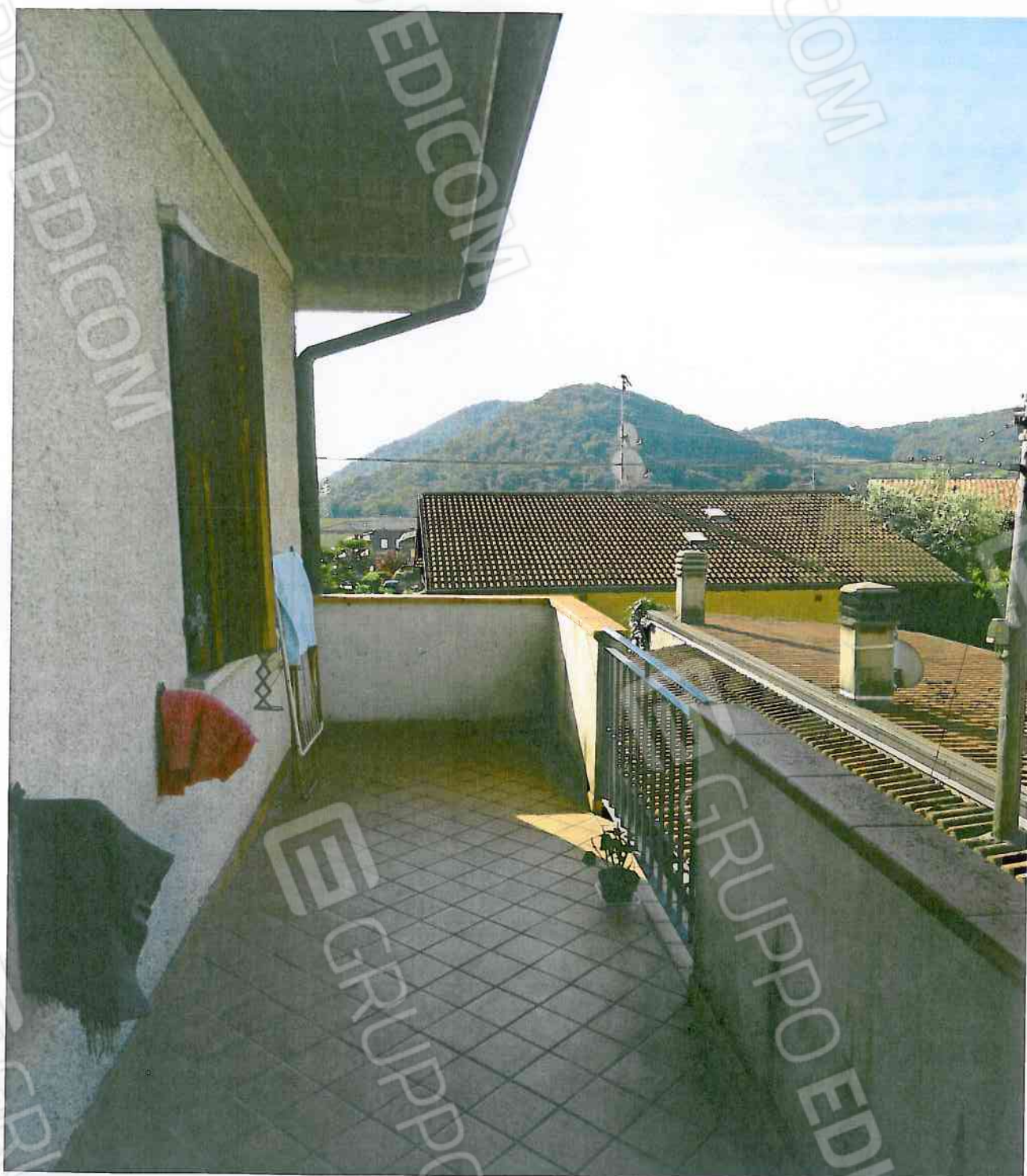
Particolare balcone fronte Sud
