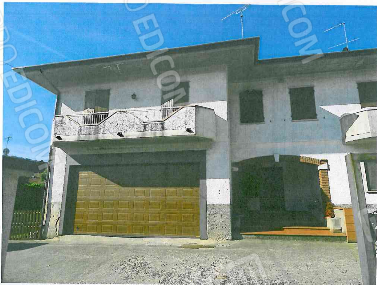
Il bene esecutato ,corpo a sinistra con l'ingresso comune con altra proprietà
