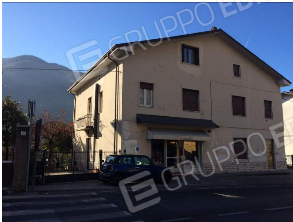
Foto 1. Fabbricato mapp. 555: prospetti su via Garibaldi e laterale d'accesso.
