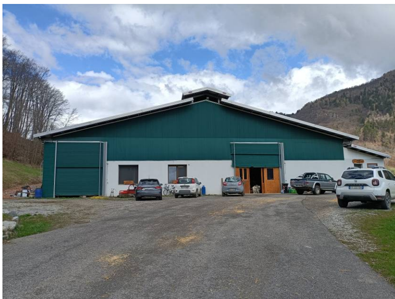
PROSPETTO PRINCIPALE: Accesso alla stalla e allo spaccio
