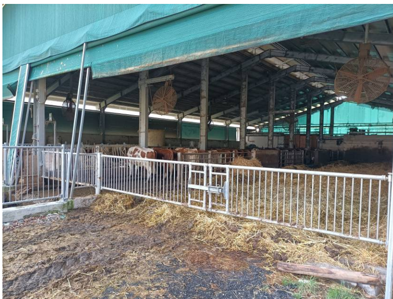
PARTE POSTERIORE DEL FABBRICATO
