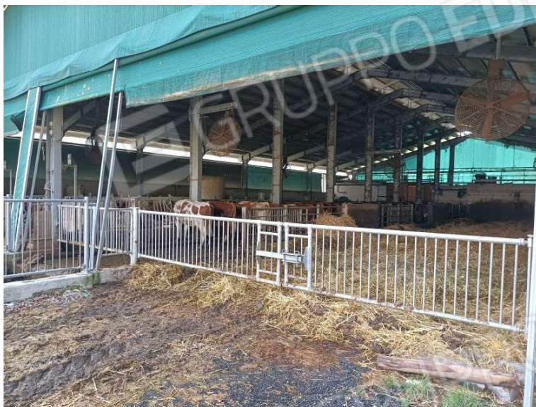
PARTE POSTERIORE DEL FABBRICATO
