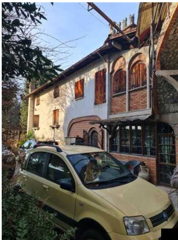
Vista 2 lato est del fabbricato
