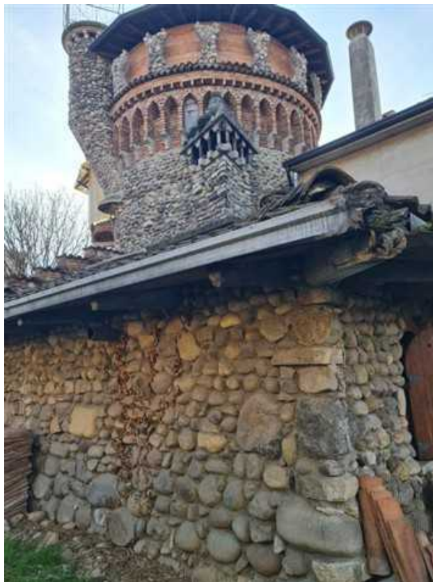
Vista lato nord del fabbricato
