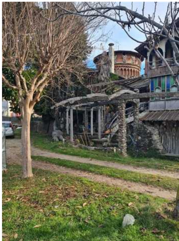
Vista 2 lato est del fabbricato con manufatti in comune
