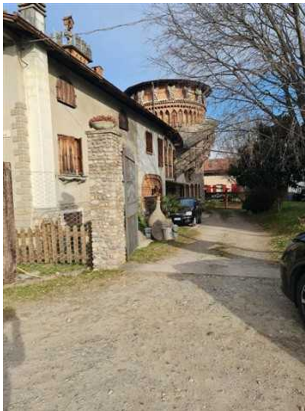
Vista primo ingresso carraio
