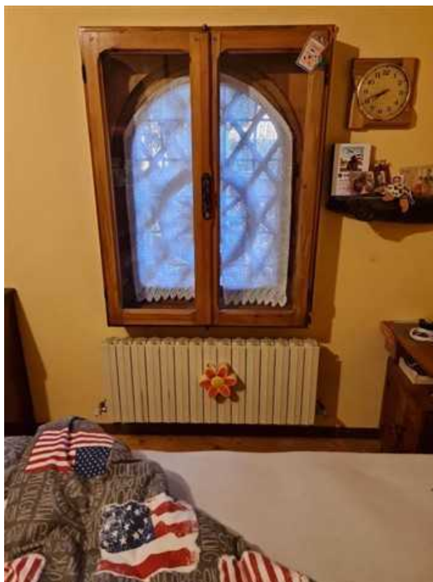
Fotografia n.8 particolare infisso e radiatore
