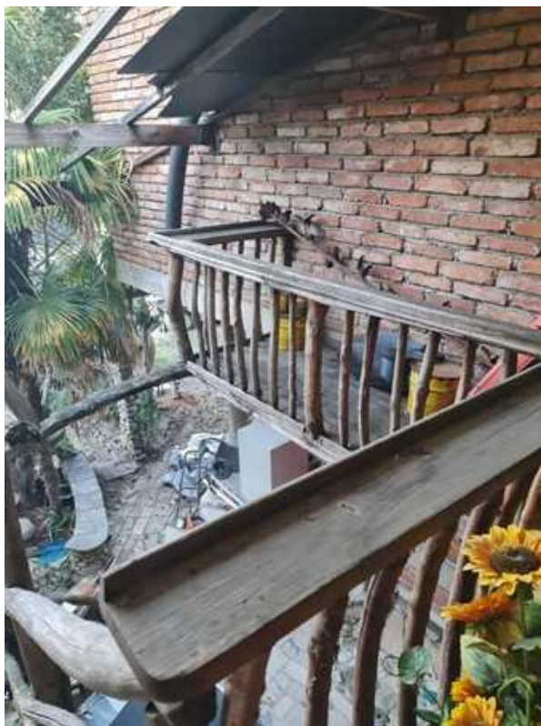
Fotografia n.2 vista balcone dall'ingresso del lotto 4
