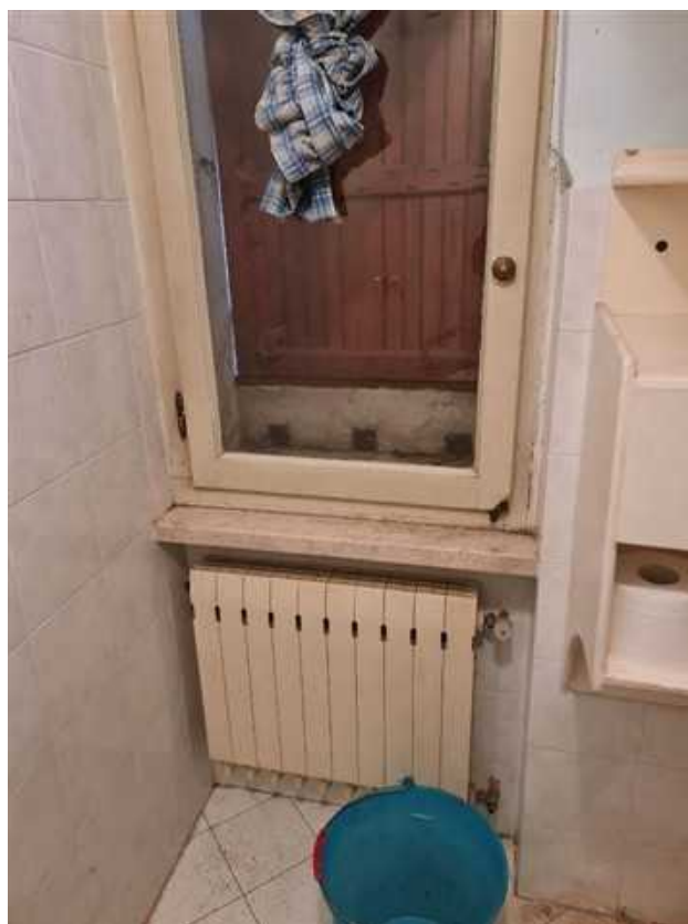
Fotografia n.6 particolare infissi e radiatori del bagno
