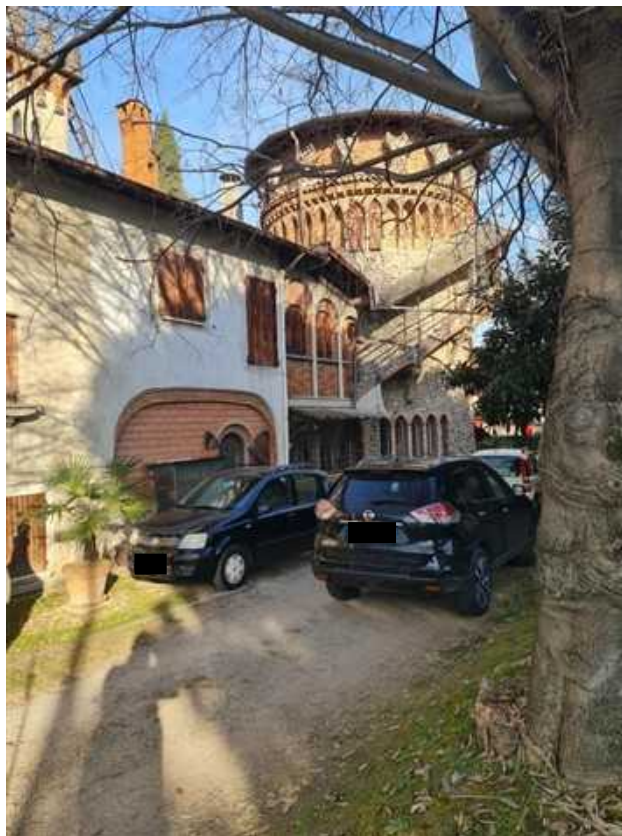
Vista lato est del fabbricato
