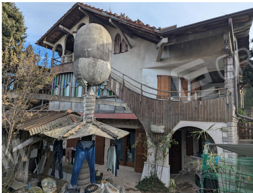
Vista lato ovest del fabbricato con manufatti in comune
