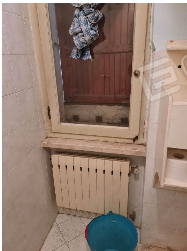
Fotografia n.6 particolare infissi e radiatori del bagno
