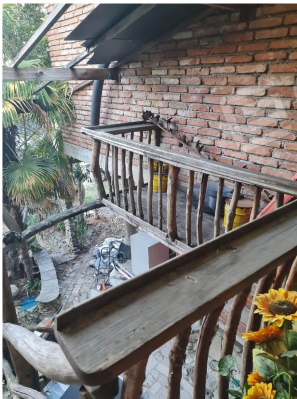
Fotografia n.2 vista balcone dall'ingresso del lotto 4
