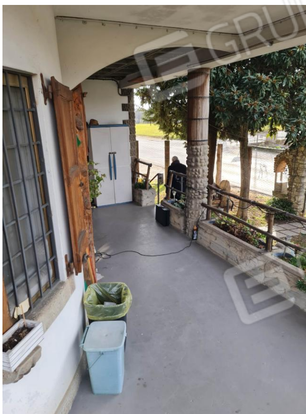
Fotografia n.13 portico comune a U. I. davanti l'ingresso del lotto 3
