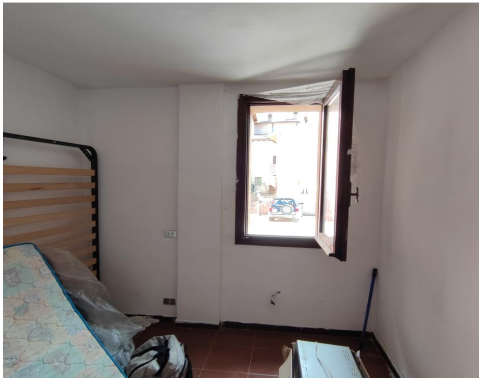
FOTOGRAFIA N. 15- LOCALE A DISPOSIZIONE VERSO IL LATO EST
