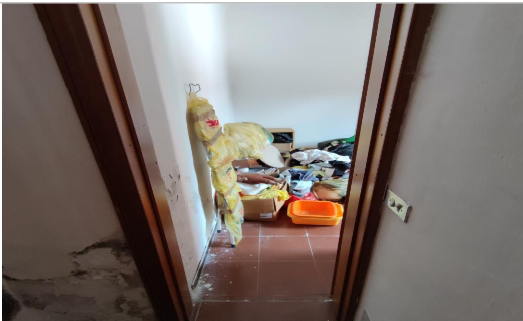
A sinistra nella fotografia i danni interni dovuti alla rottura impianto idrico ( zona disimpegno)
