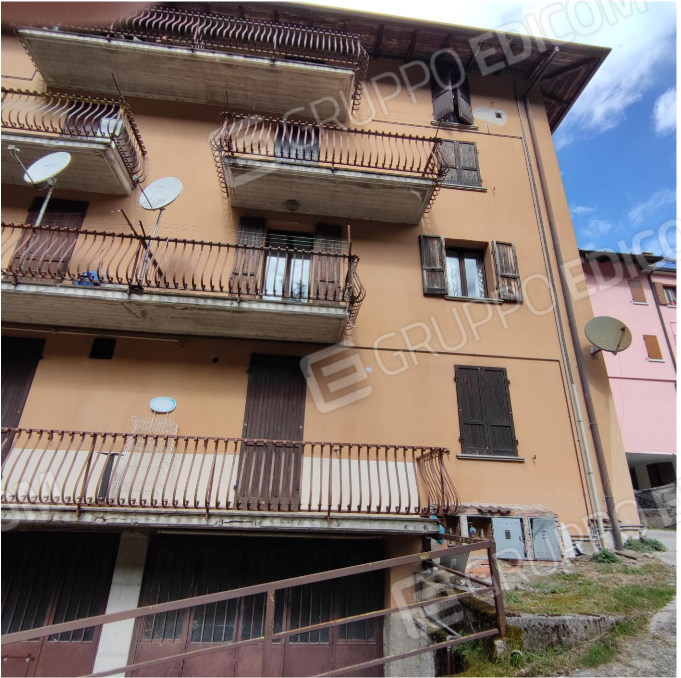
FOTOGRAFIA N.6 – IL CORPO EST DEL CONDOMINIO OVE SI AFFACCIA , VERSO SUD,AL PIANO PRIMO , L'UNITA' ABITATIVA ESECUTATA
