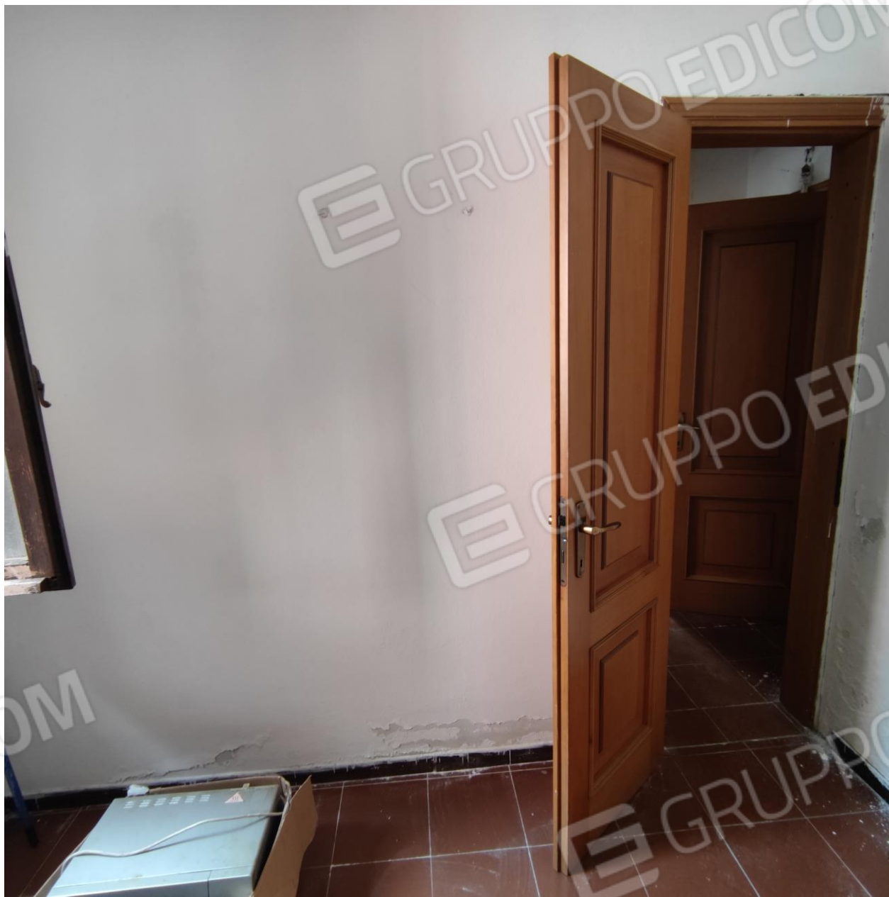
FOTOGRAFIA N. 17 - LOCALE A DISPOSIZIONE LATO SUD
