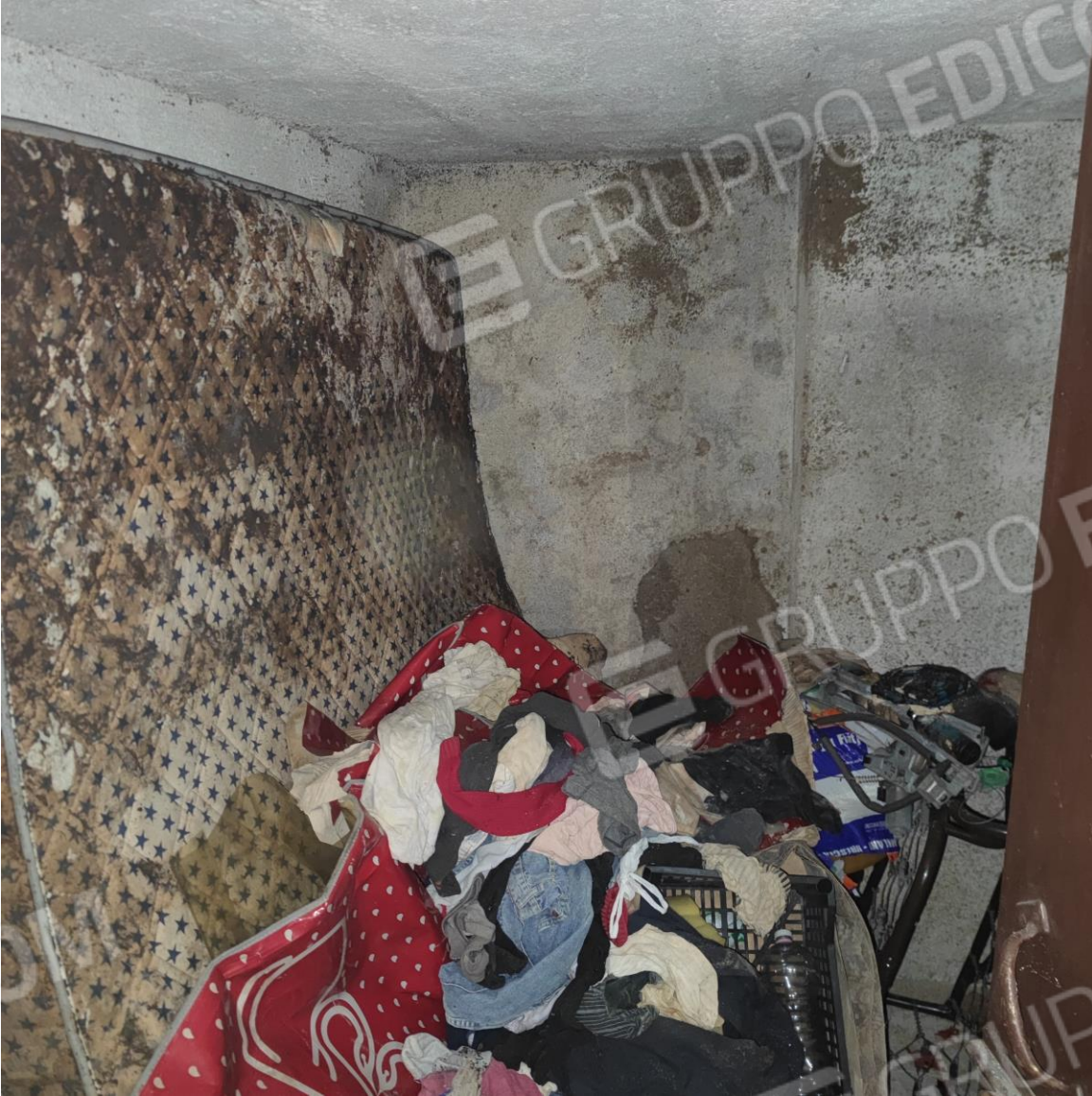
FOTOGRAFIA N. 21 –CANTINA AL PIANO AMMEZZATO
