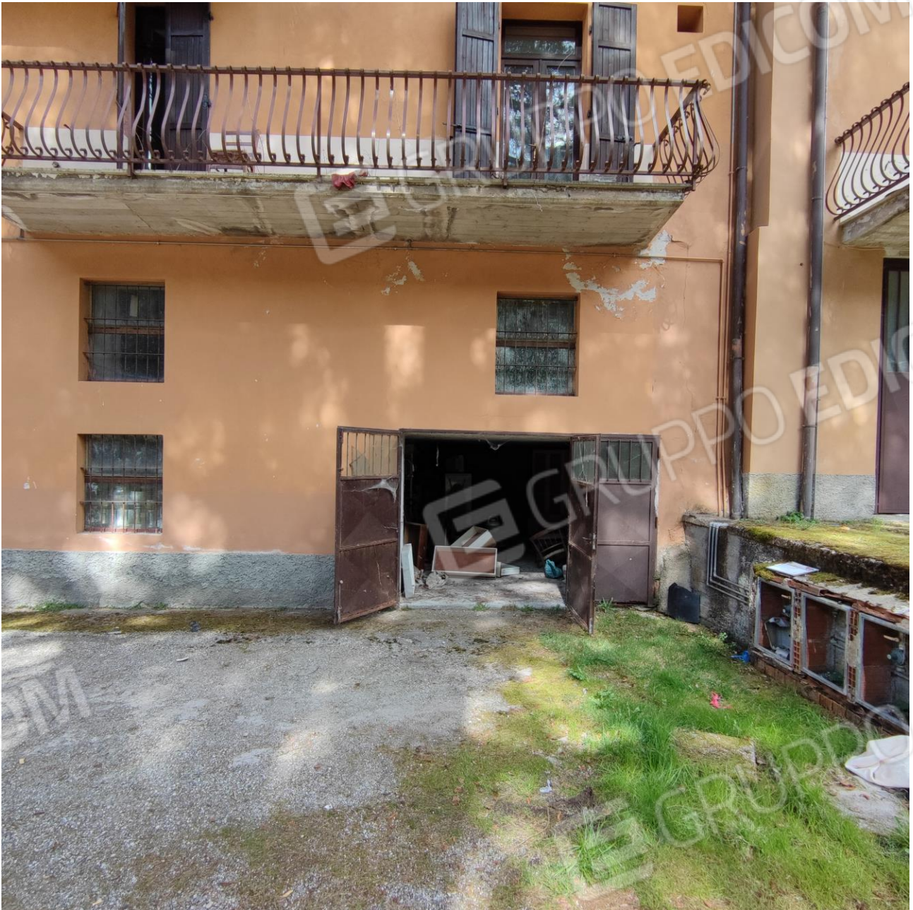
FOTOGRAFIA N. 19 -INGRESSO ALLE UNITA' ESECUTATE ACCATASTATE AUTORIMESSE
