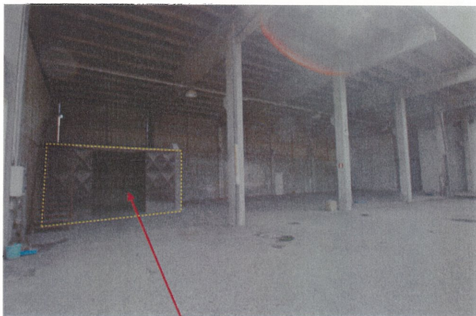
Ripostiglio non autorizzato.
