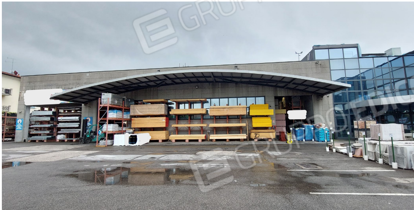
Vista magazzino da corte interna
