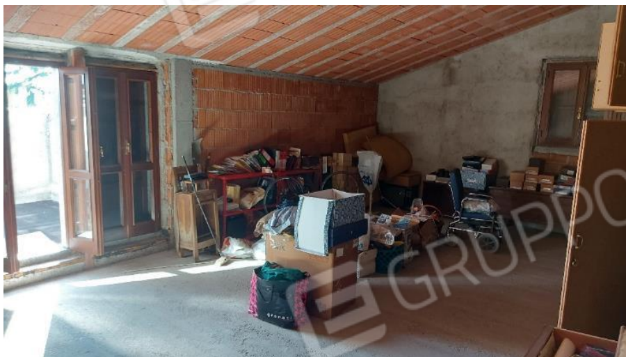
PIANO PRIMO – SOFFITTA AL RUSTICO
