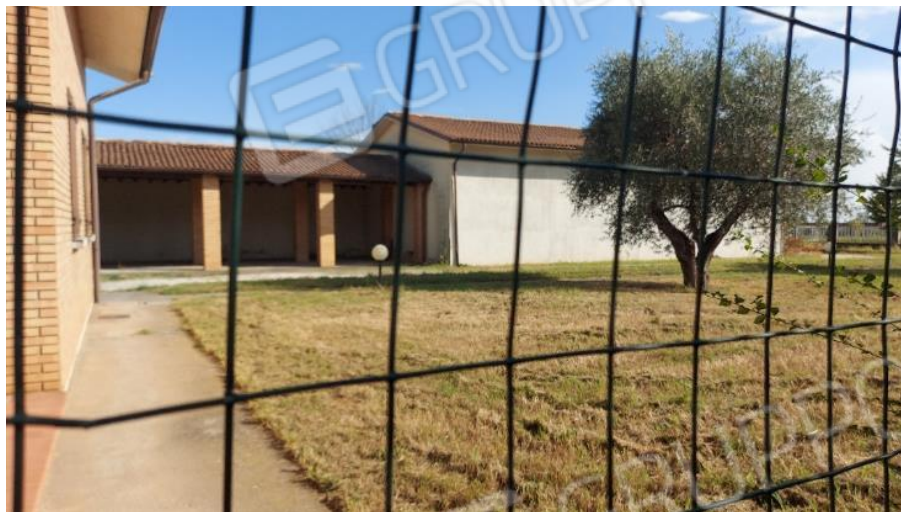
DEPOSITO MACCHINARI AGRICOLI (SUB. 21) – PROSPETTO OVEST
