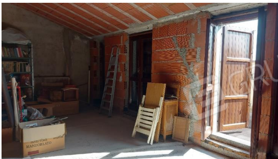
PIANO PRIMO – SOFFITTA AL RUSTICO
