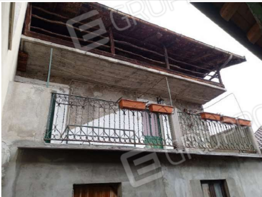
N. 25 - Dettaglio balconi ai piani primo e sottotetto
