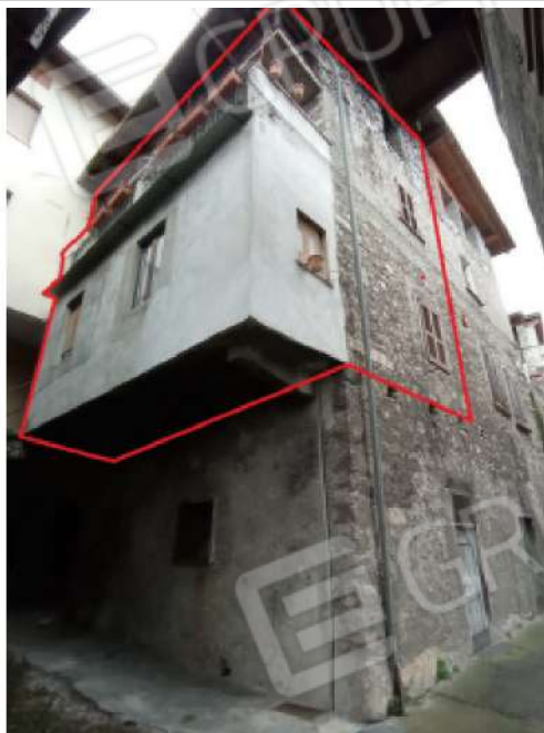
N. 17 - Vista lati sud ed est con la porzione immobiliare.
